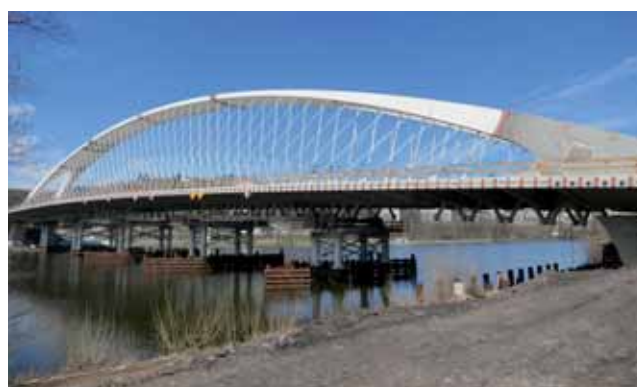
Obrázek 25: Zahájení demontáže provizorní příhradové konstrukce
