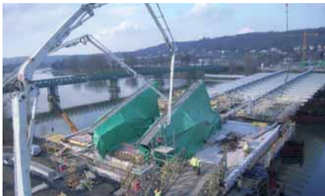
Obrázek 9: Betonáž zárodku samozhutnitelným betonem
