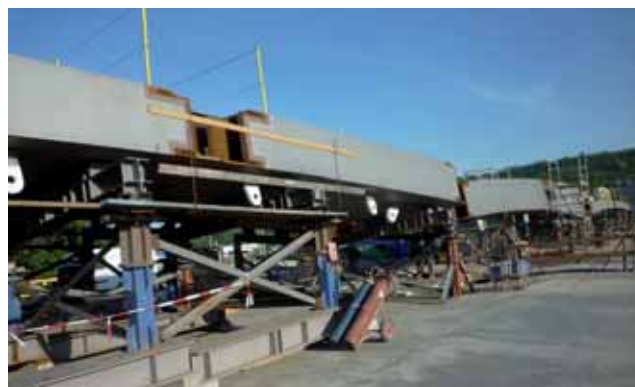
Obrázek 14: Dílce oblouku na trojské předmontážní ploše
