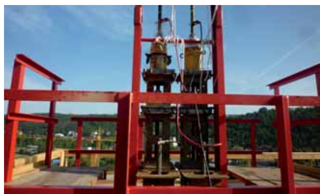
Obrázek 21: Duté hydraulické válce zvedající část oblouku na závěsných tyčích
