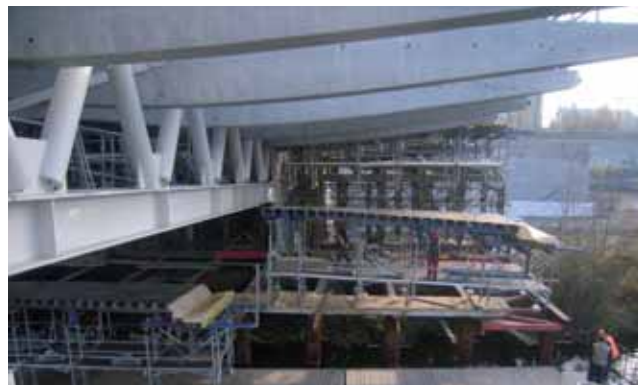
Obrázek 10: Manipulace s bedněním nosné konstrukce
