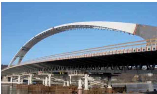
Obrázek 22: Oblouková konstrukce po demontáži provizorních věží PIŽMO
