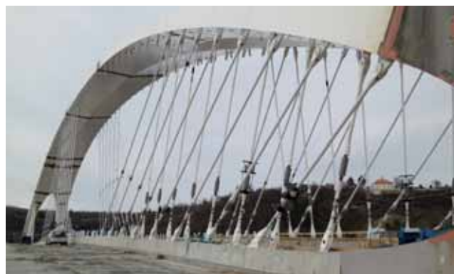
Obrázek 23: Instalace závěsů Macalloy na obloukové konstrukci
