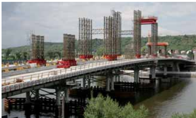
Obrázek 15: Provizorní věže z materiálu PIŽMO
