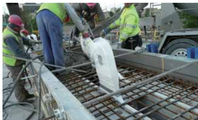
Obrázek 12: Betonáž spřažené konstrukce táhla oblouku
