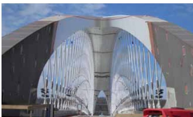
Obrázek 24: Dokončená instalace závěsů Macalloy
