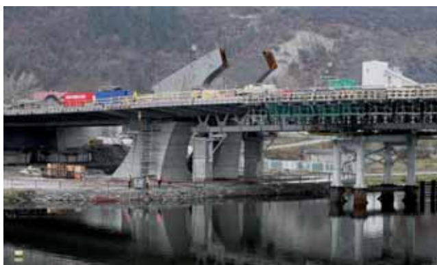
Obrázek 11: Osazené bednění nosné konstrukce
