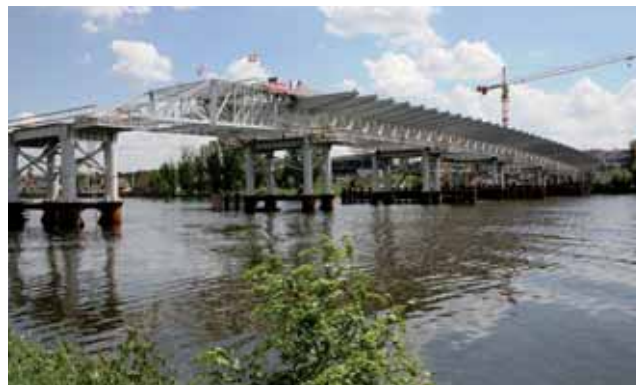
Obrázek 6: Výsun provizorní příhradové konstrukce
