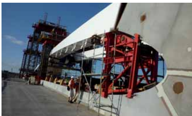
Obrázek 17: Krajní díl oblouku osazený v čepu
