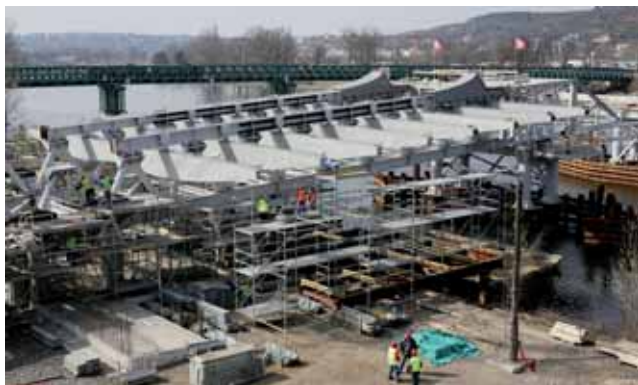
Obrázek 5: Výroba pro montáž provizorní příhradové konstrukce, táhla a příčníků
