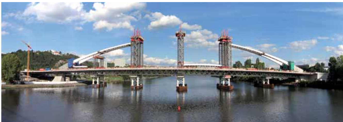
Obrázek 19: Krajní díly oblouku v definitivní poloze
