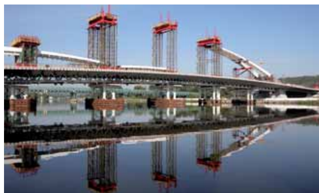
Obrázek 18: Zvedání krajního dílu oblouku na trojské straně
