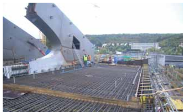
Obrázek 8: Osazený zárodek a betonářská výztuž nosné konstrukce
