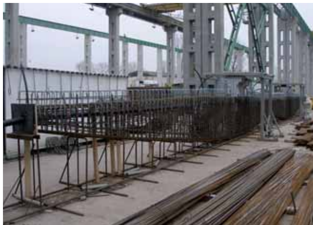
Obrázek 4: Osazený kotevní přípravek do armokoše příčníku
