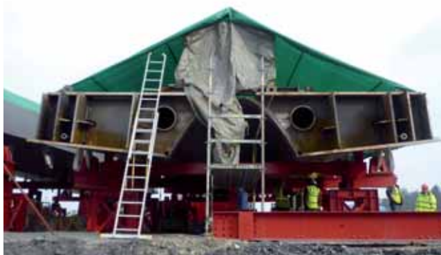
Obrázek 13: Předmontáž oblouku na holešovické straně
