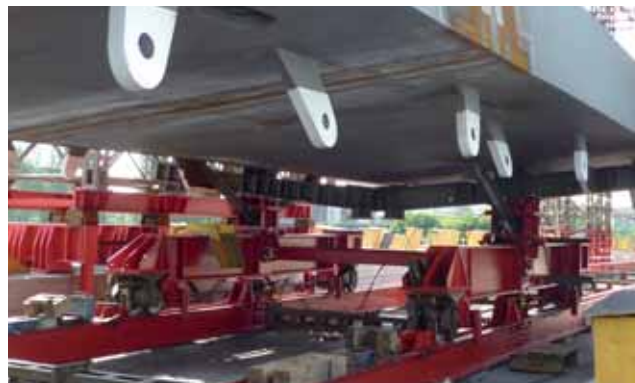
Obrázek 16: Zavážení ocelových dílců oblouku pomocí hydraulicky ovládaných vozíků
