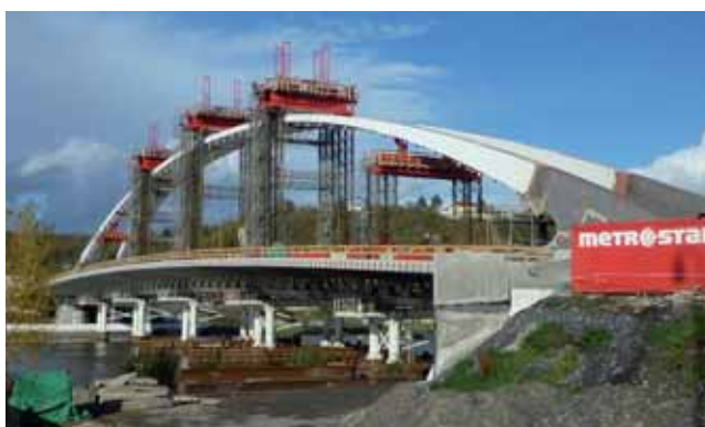
Obrázek 20: Stav dokončení zvedání všech dílů oblouku
