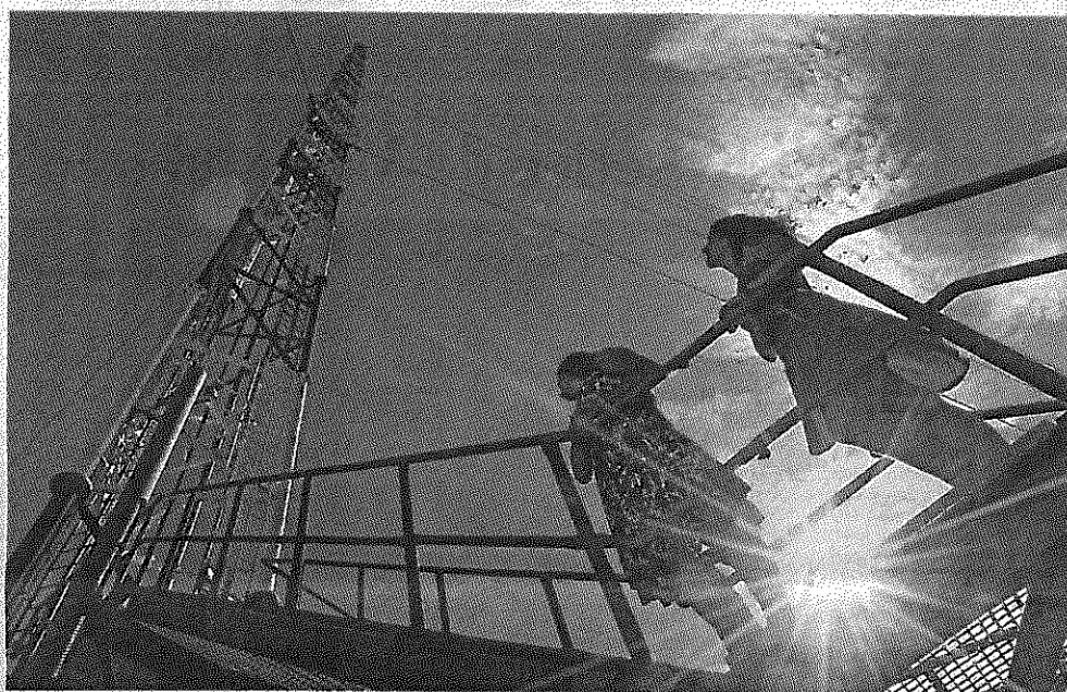
Konec v nedohlednu Stožár tvoří 6 ocelových dílců. Základy jsou zabetonované hluboko do země. Stabilitu zajišťuje 15 ocelových lan, které jsou dohromady dlouhé dva a půl kilometru. Napnuté jsou do tří směrů, vždy po pěti lanch uchycených v různých výškách.
