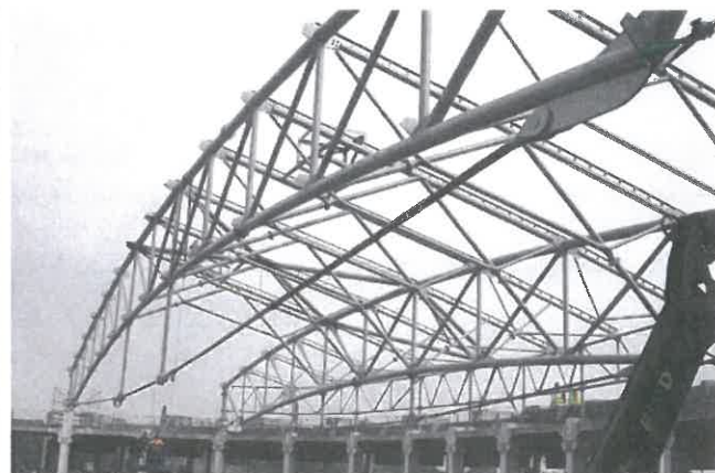
Vozníky propojené portálovými ztužidly
