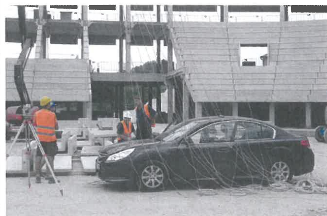
Měřící vozidlo při předpínání táhel
