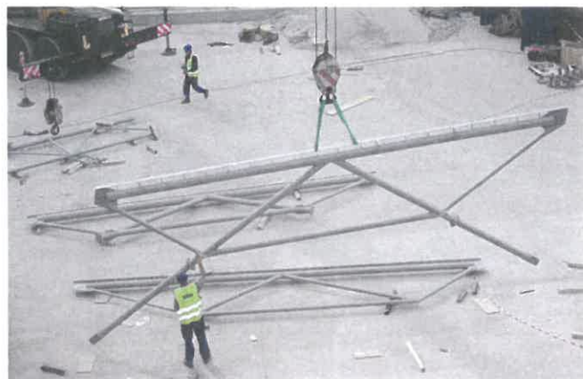
Předmontáž portálového ztužidla na budoucí ledové ploše
