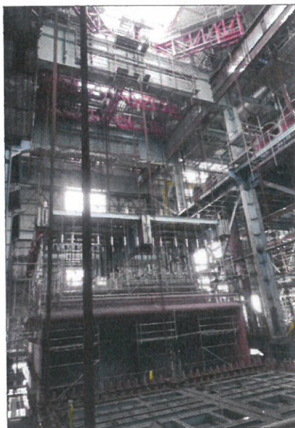
Obr. 18 – PPK a zavěšené části nového kotle v průběhu zdvihu
