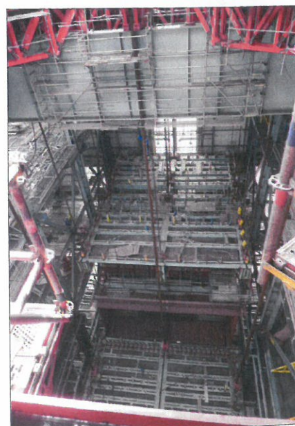
Obr. 19 – PPK a zavěšené části nového kotle v průběhu zdvihu
