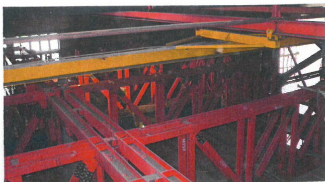
Obr. 13 – Nosníky kolmé na osu kotle
