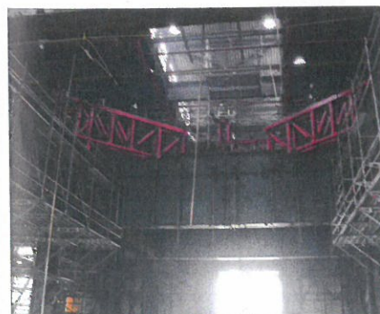
Obr. 17 – Nosníky 1. tahu směrem k mezitahu
