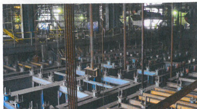
Obr. 15 – Nosný rošt 2. tahu a mezitahu stávajícího kotle při spuštění
