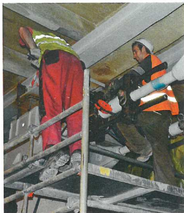
Obr. 6: Dotahování středních matic pomocí ručních řetězků
