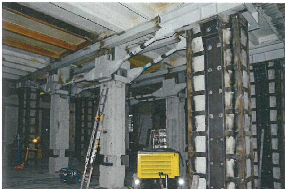
Obr. 3: Osazení vzpínadla na sloup zesílený opásáním ocelovými prvky
