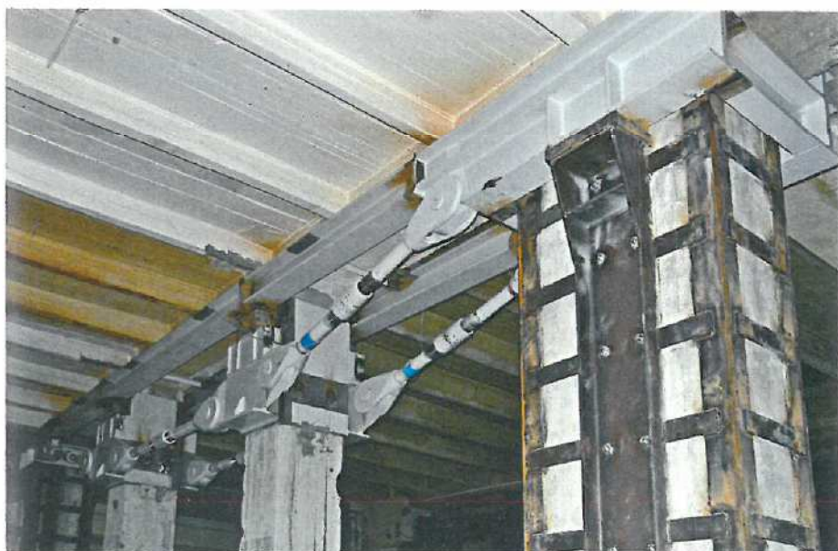
Obr. 4: Kompletně osazené vzpínadlo před aktivací
