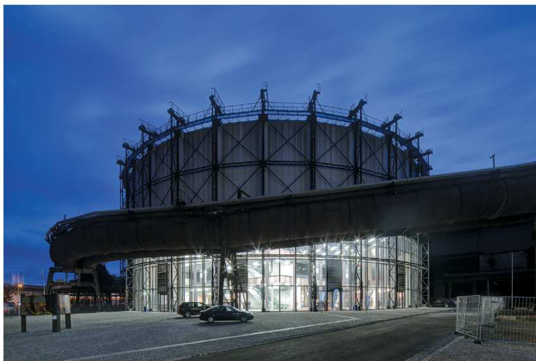
Plynojem po rekonstrukci – přístupový prostor Gasholder after conversion – access space
