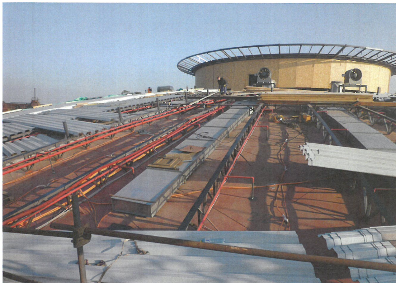
Montáž vzduchotechniky, střešního pláště a opláštění tamburu
