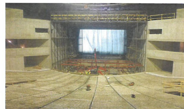
Montáž jeviště s proskleným otvorem
