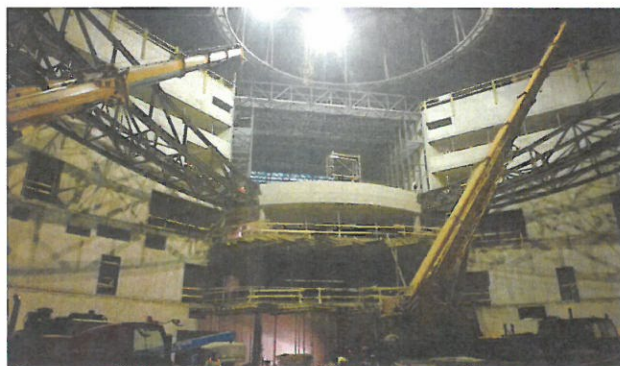
Montáž vazníku hlediště
