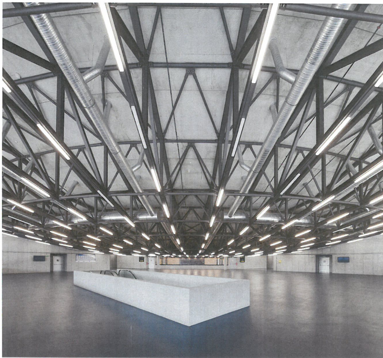
Ocelová konstrukce hlediště ve tvaru lastury
