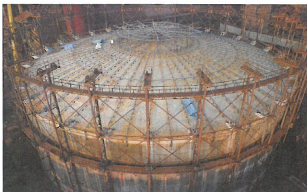
Zdvih zvonu – vnější pohled
