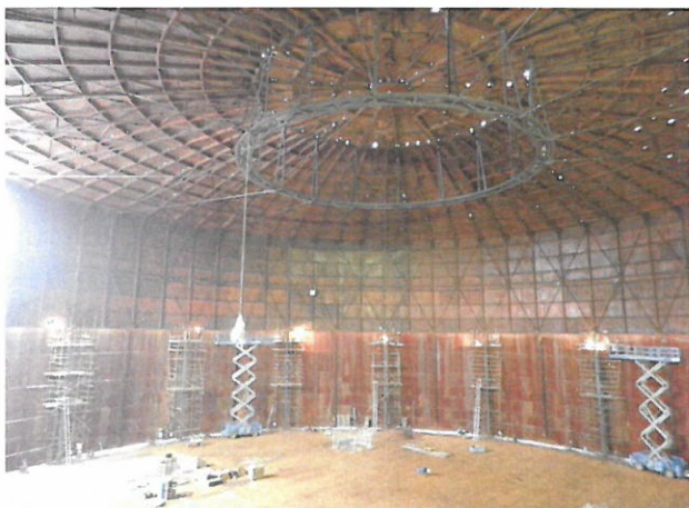
Zdvih zvonu – pohled zevnitř
