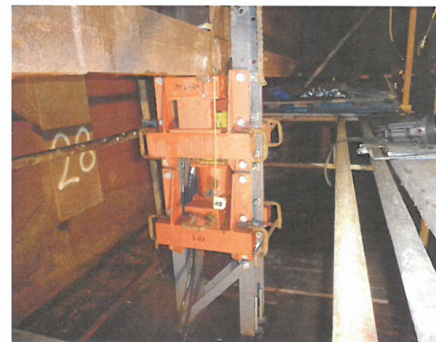
Pomocné konstrukce a hydraulika pro zdvih zvonu
