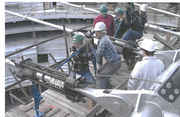
Předpínání táhel s použitím hydraulického zařízení
