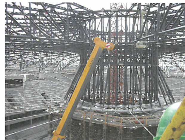
Styk vazníků a táhel s centrálním tubusem
