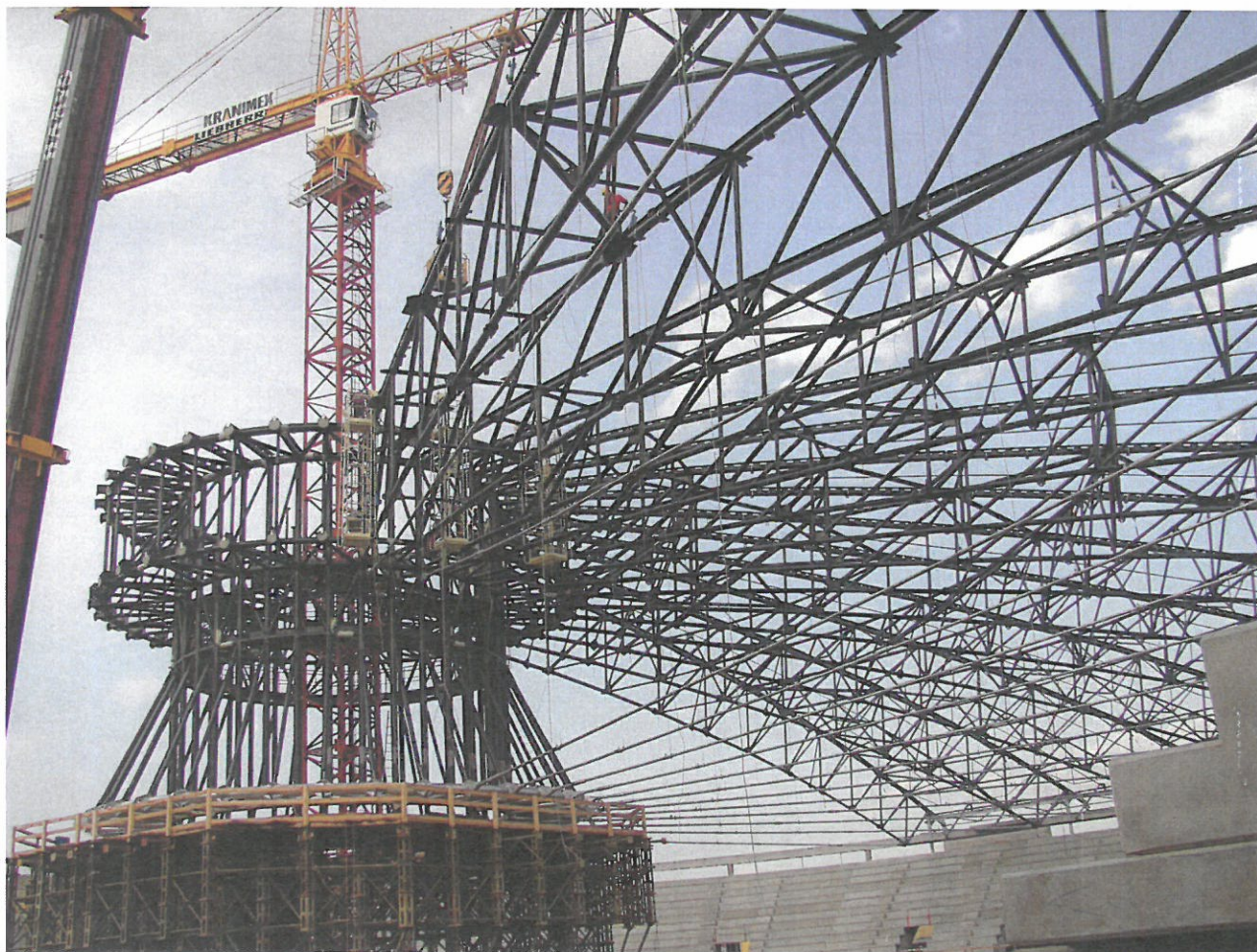
Konstrukce po dokončení vazníků
