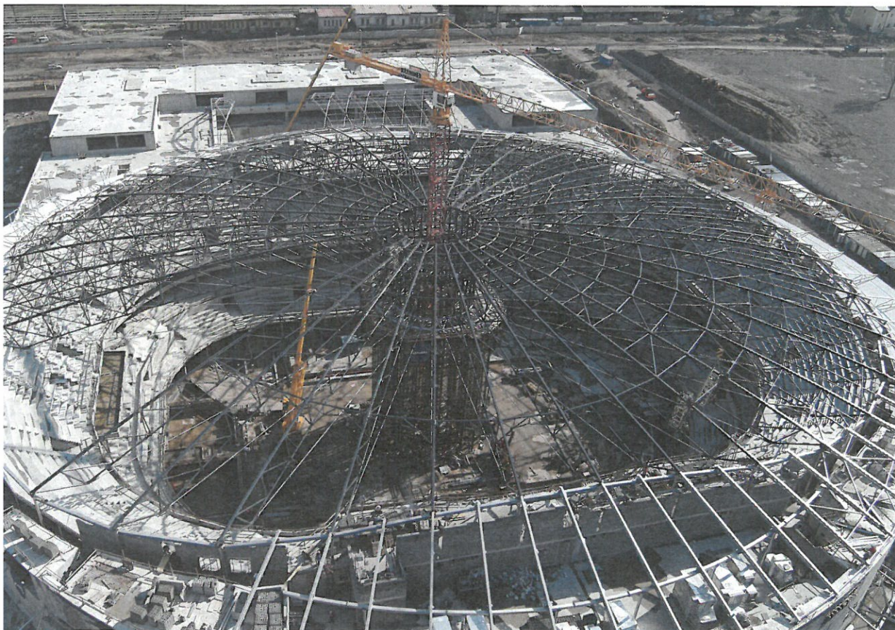
Montáž vazníků, táhel a ztužidel, střední jeřáb pro montáž ztužidel a střešních panelů
