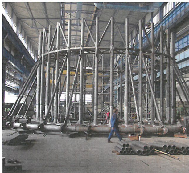
Předmontáž spodní části tubusu
