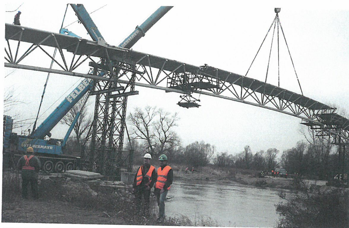
Uloženie záverečného diela hlavného poľa Placing the final part of the main span
