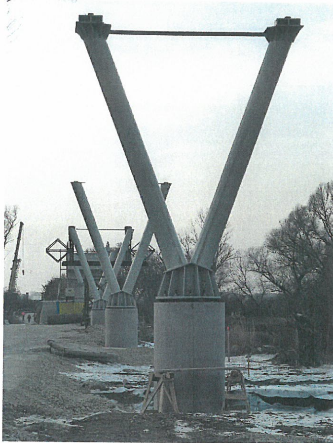
Ocelové podpory mostu Steel piers of the bridge
