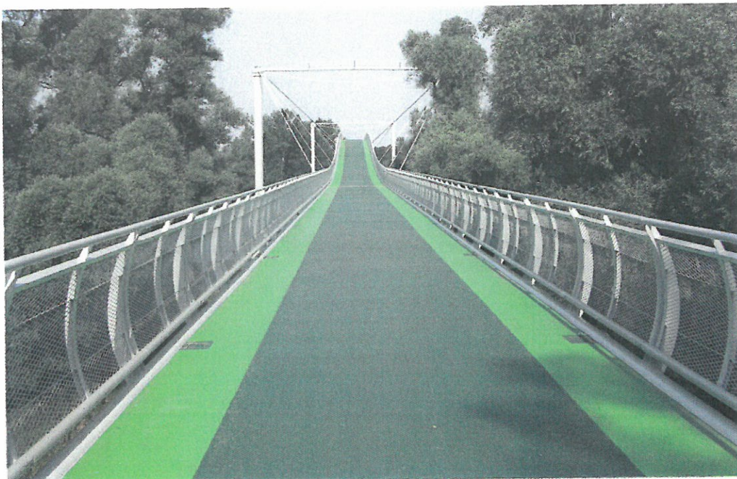
Pohľad na dokončený most View of the finished bridge
