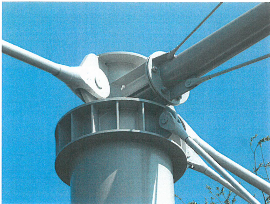
Głowa pylonu Detail of the top of the pylon
