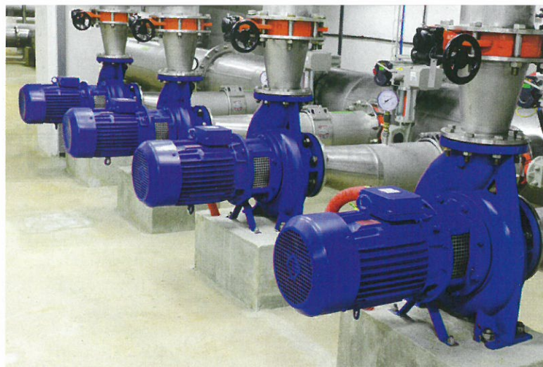
▲ Rekonstrukce a rozšíření úpravny vody v aglomeraci Kroměříž
