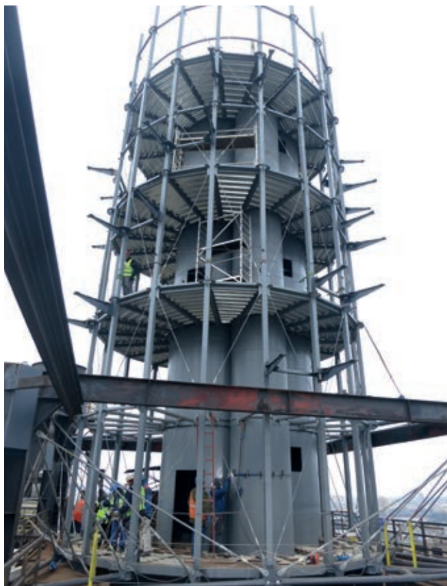
Ocelová konstrukce nástavby
