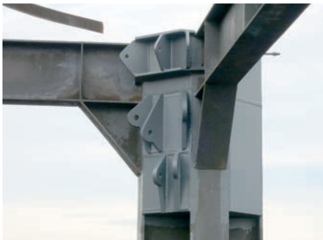
Doplňené styčníky v původní konstrukci pece pro zavěšení nástavby
