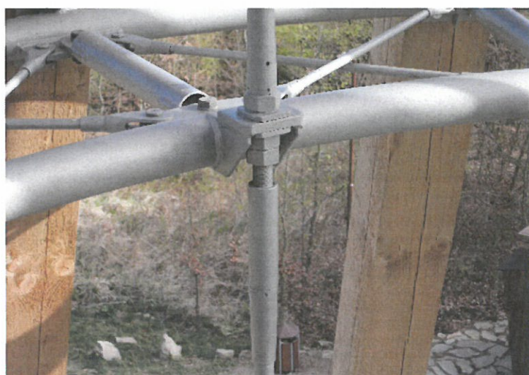
▲ Obr. 10. Spoj táhla se ztužidlem
