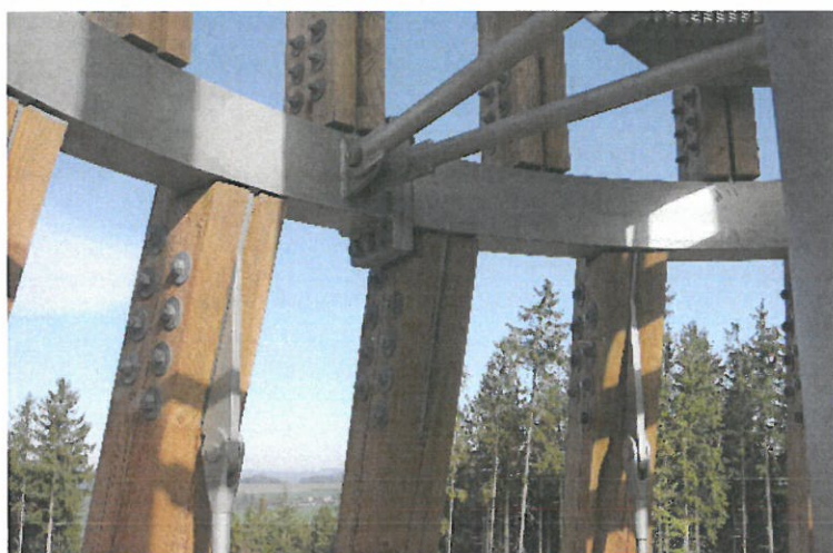
▲ Obr. 8. Detail prstence a kotvení táhel
