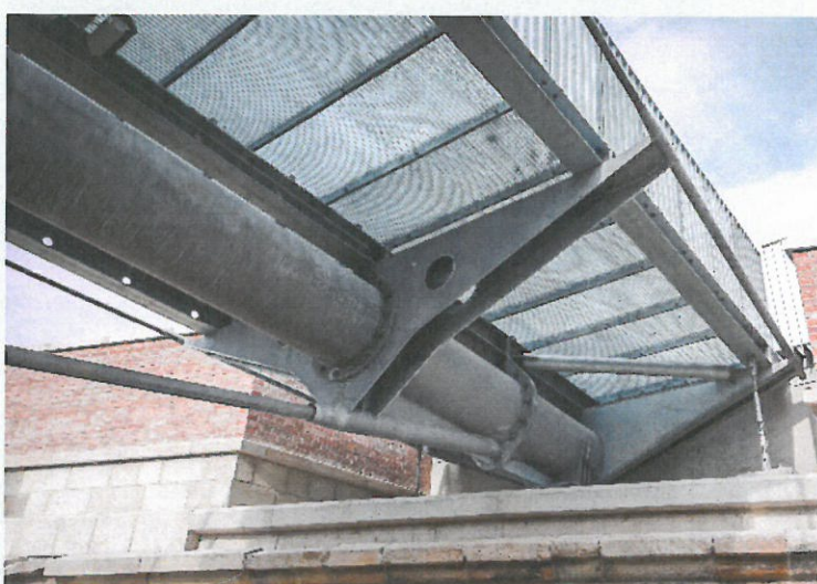
▲ Obr. 13. Koncový díl se stabilizačním táhlem (foto: Tomáš Vojtíšek)
