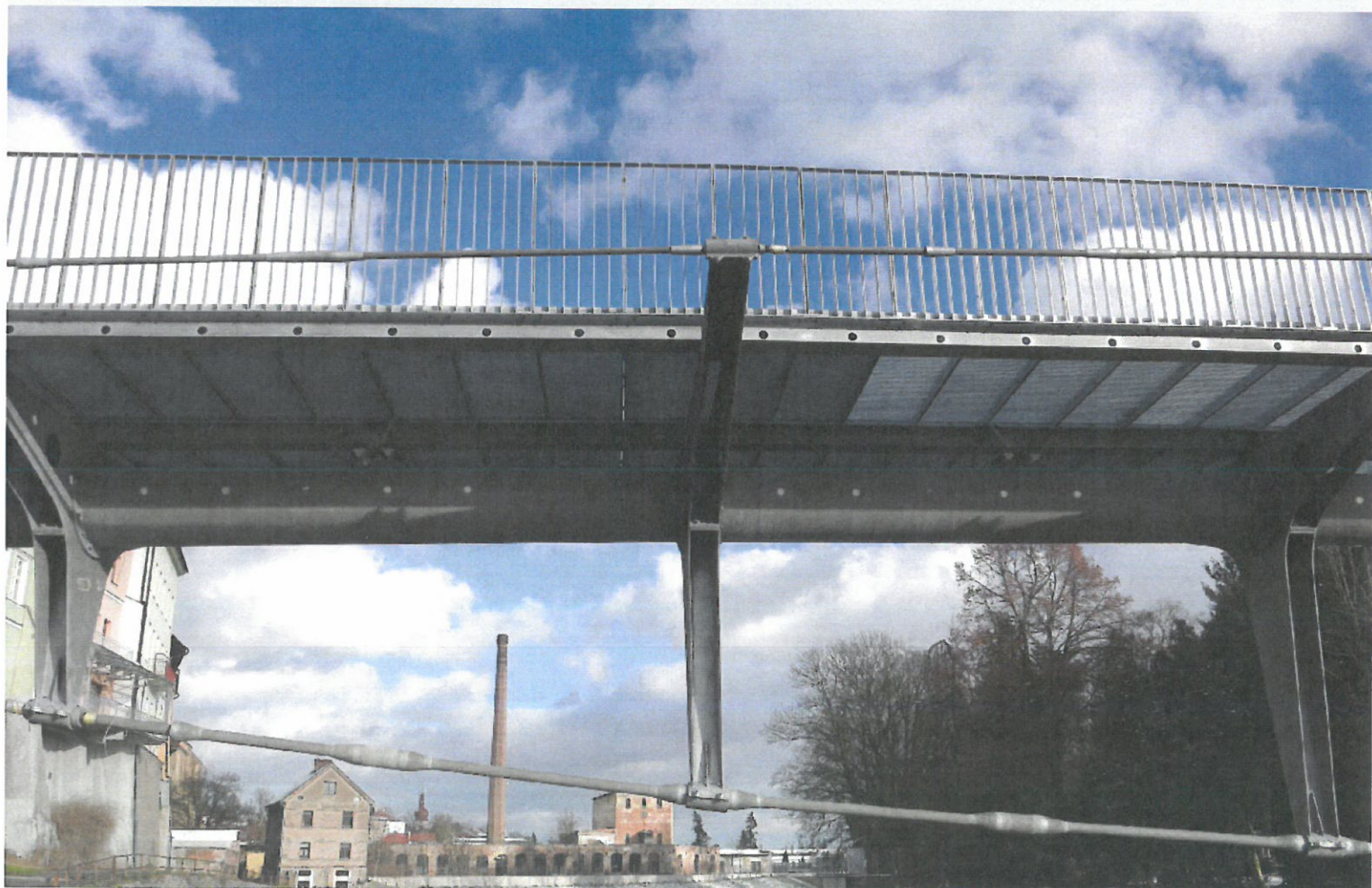
▼ Obr. 8. Detail příčniku s konstrukčními návaznostmi
