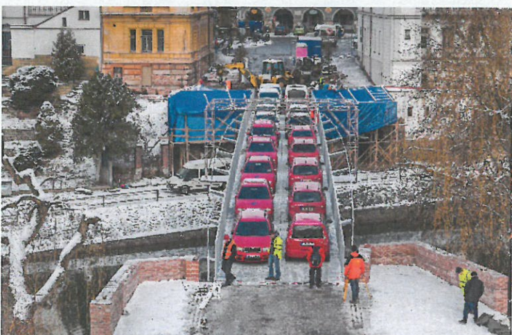
▲ Obr. 14. Statická zatěžovací zkouška (foto: Tomáš Vojtíšek)
