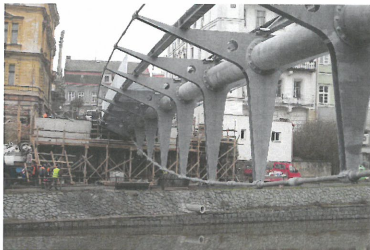
▲ Obr. 11. Most po usazení na ložiska
