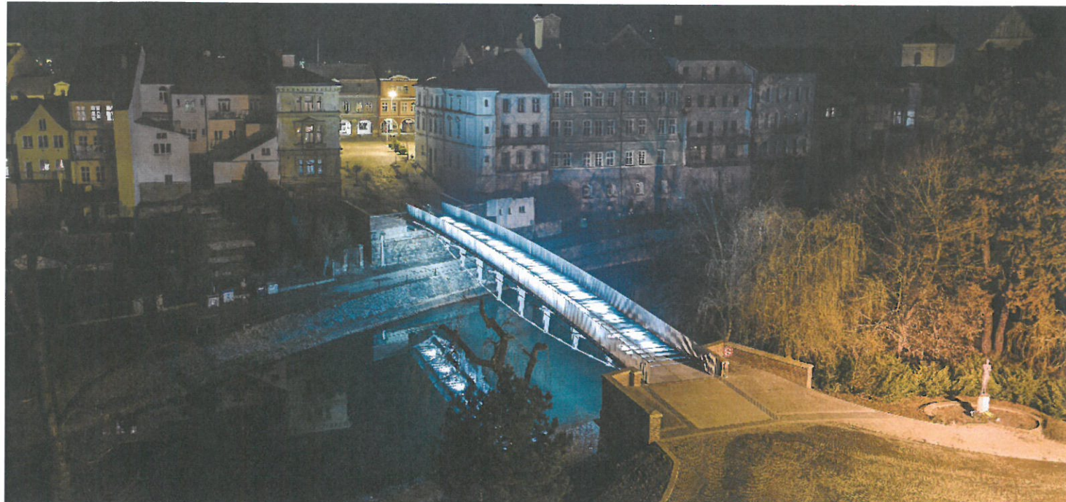
▲ Obr. 17. Noční pohled na osvětlenou konstrukci mostu (foto: Tomáš Vojtíšek)
