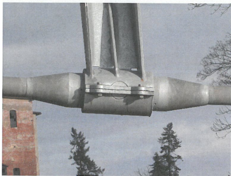
▲ Obr. 6. Spojka táhel kloubově uložená v objímce příčniku
