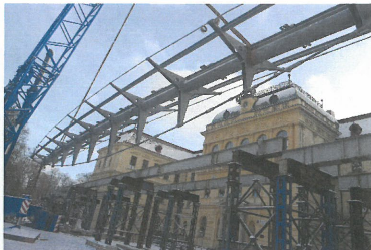
▲ Obr. 10. Zdvih konstrukce z montážních podpěr
