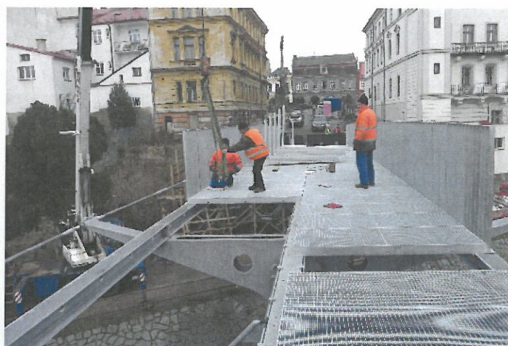
▲ Obr. 12. Montáž porořostové mostovky
