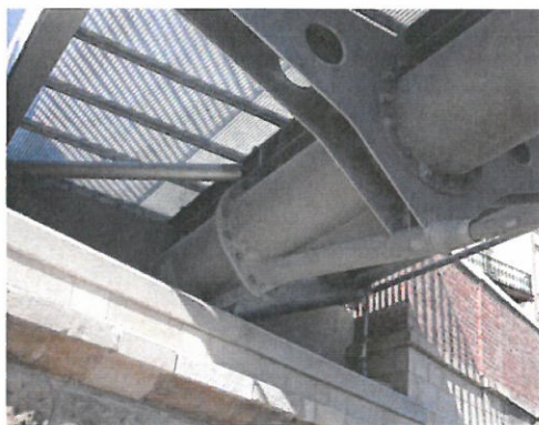
Detail koncové části mostu
