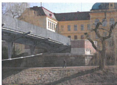
Pravobřežní opěra po rekonstrukci
