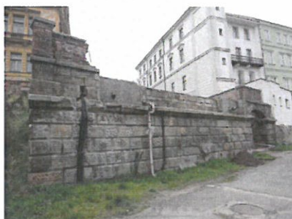
Původní stav levobřežní opěry
