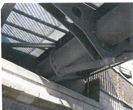
Detail koncové části mostu
