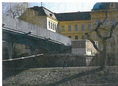
Pravobřežní opěra po rekonstrukci
