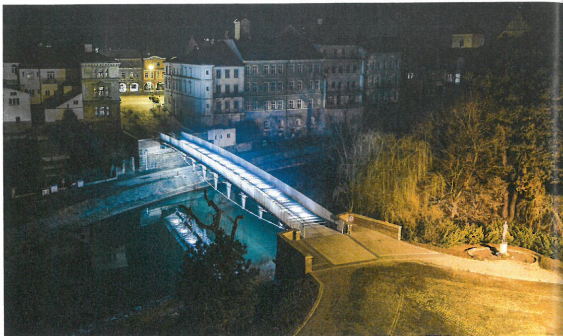
Celkový snímek mostu při nočním osvětlení
