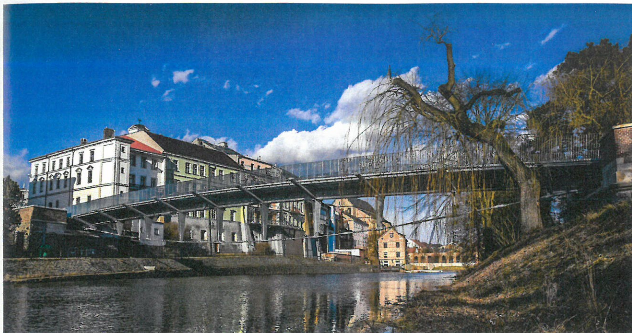
Pohled na transparentní vzpínadlovou konstrukci
