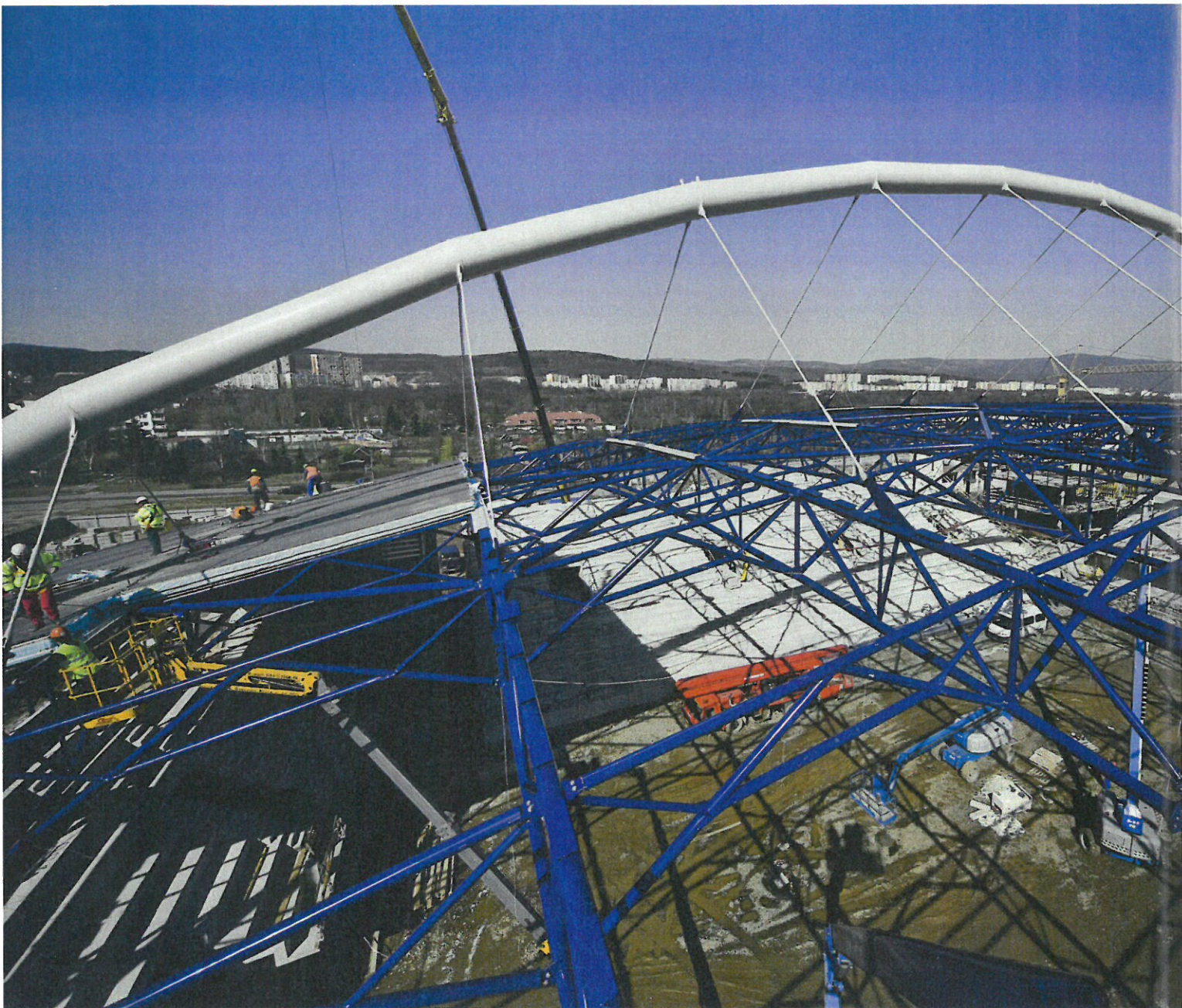
▲ Ocelová konstrukce zastřešení hokejové arény v Chomutově (foto: Tomáš Malý)
