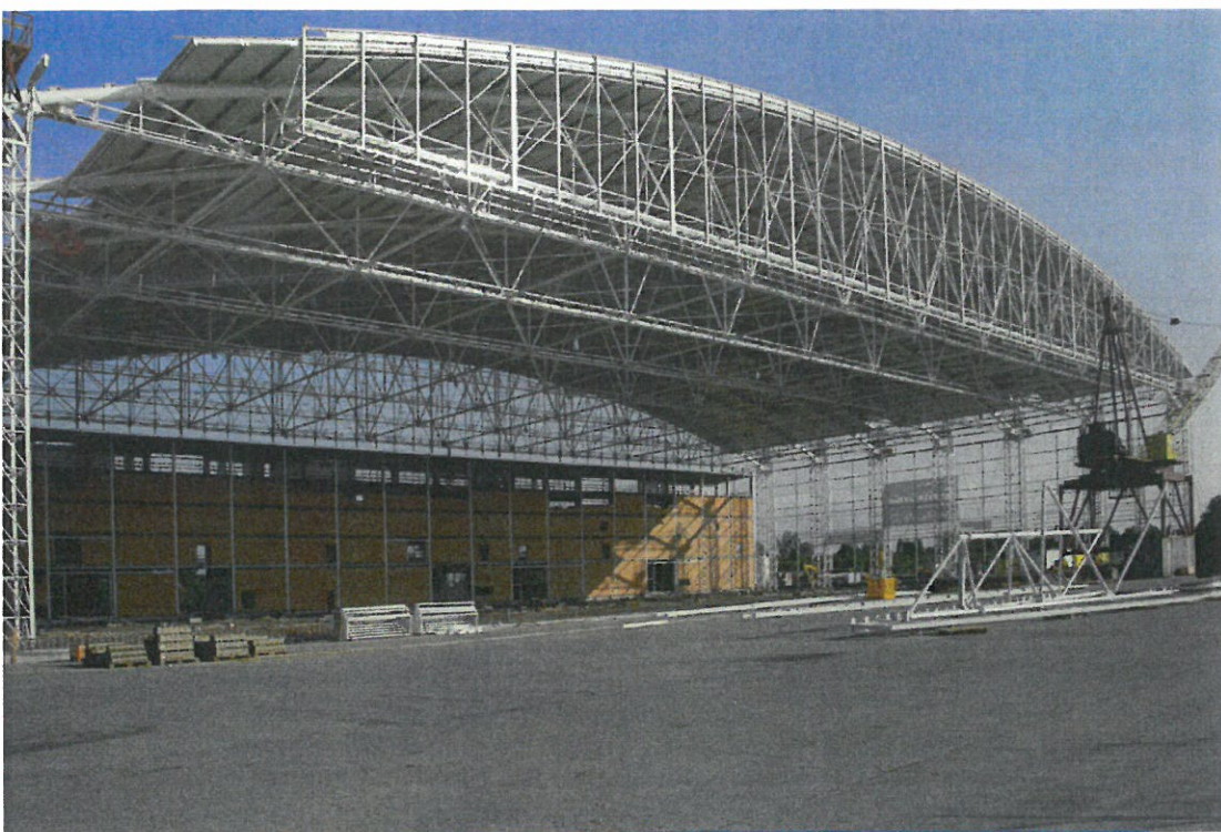
▲ Nosná ocelová konstrukce hangáru Mošnov
