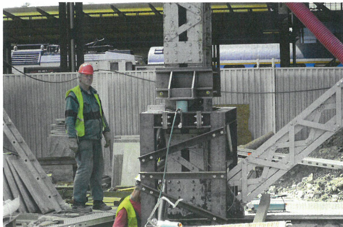
▼ Výměna části sloupu při rekonstrukci ocelových konstrukcí zastřešení nástupišť Praha hlavní nádraží
