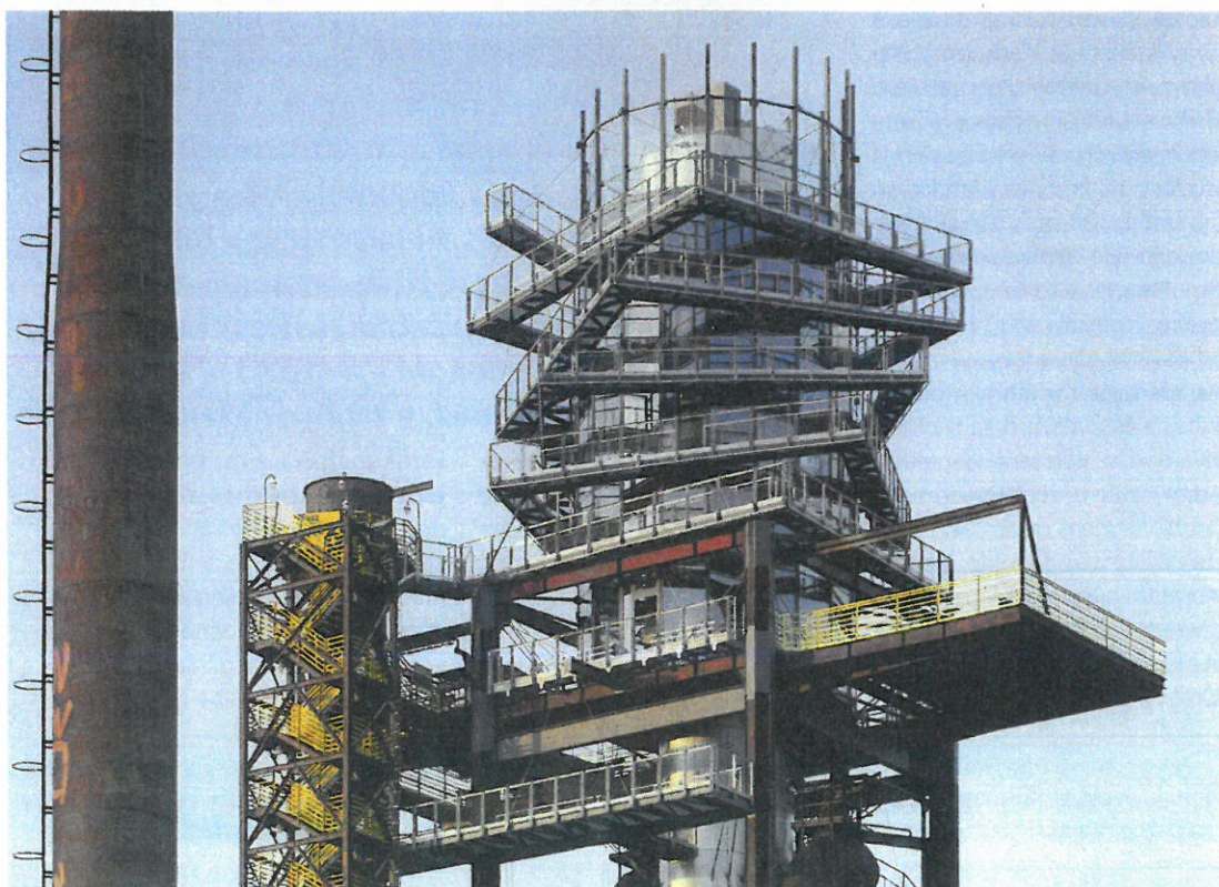
▼ Přeměna vysoké pece ve Vítkovících na vyhlídkový objekt s prosklenou nástavbou
