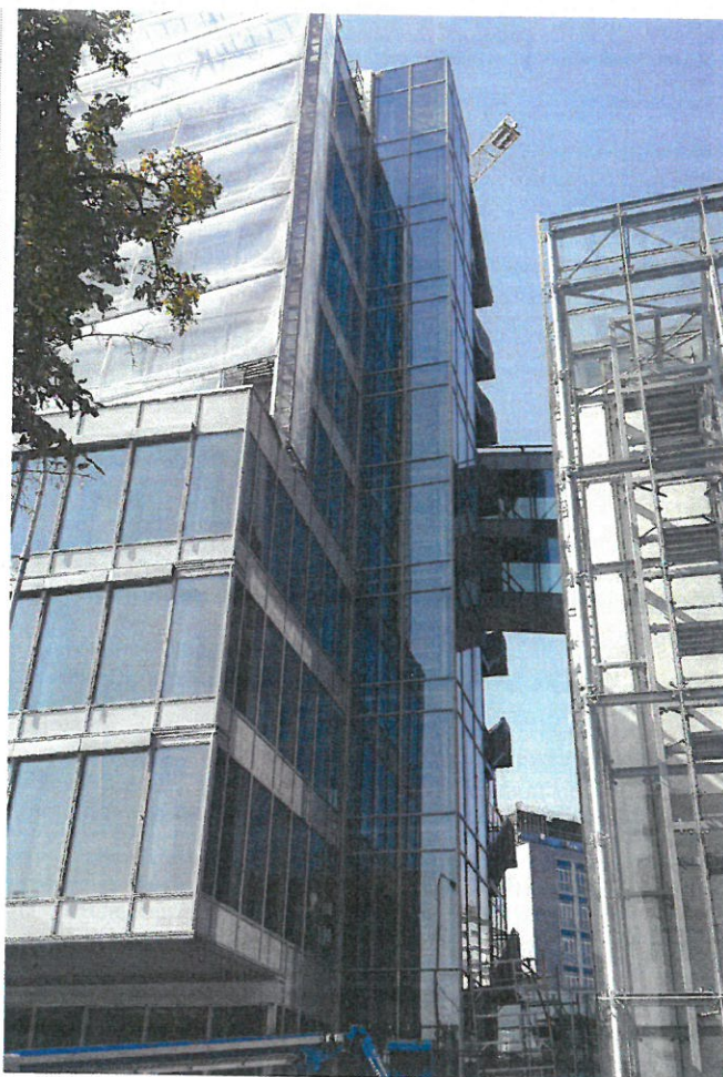
Pohled ze severní strany na prosklený výtah a spojovací krček
