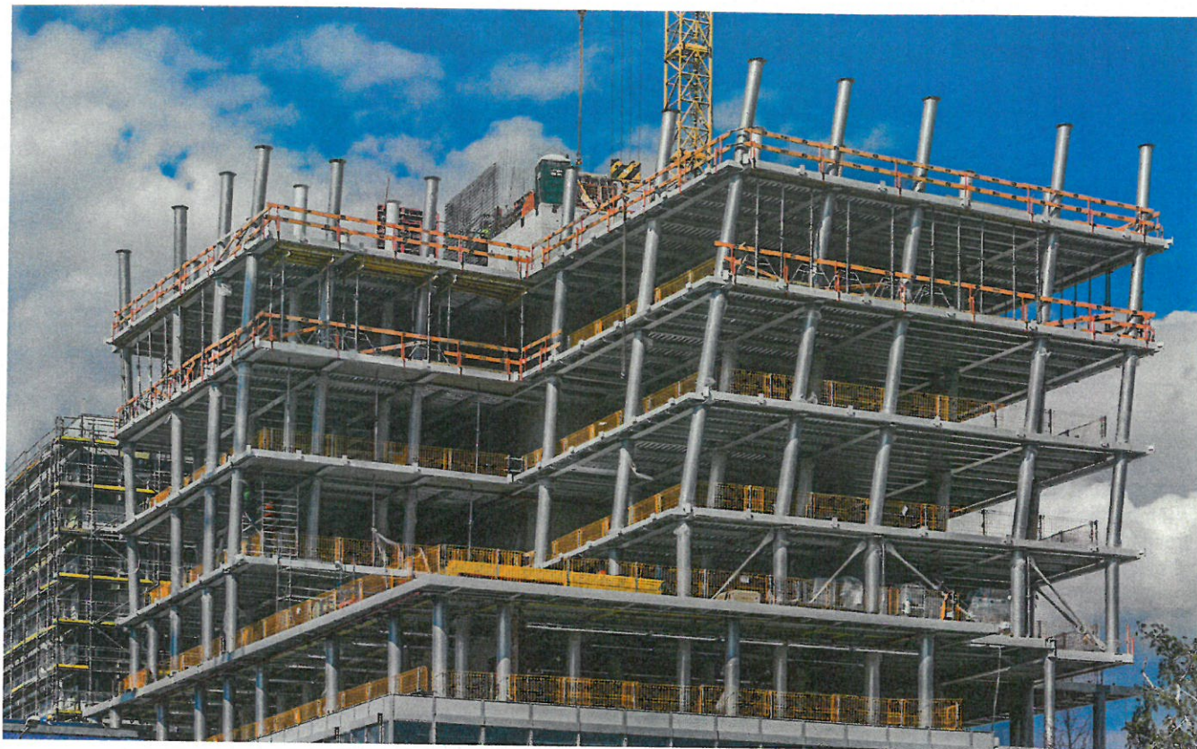
Ocelová konstrukce budovy při výstavbě – vrchní šikmá část
