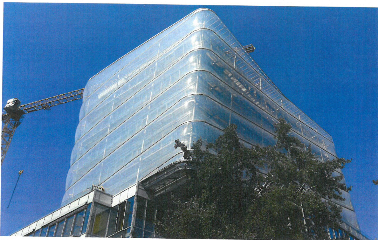
Konstrukce fasády ETFE po kompletní montáži
