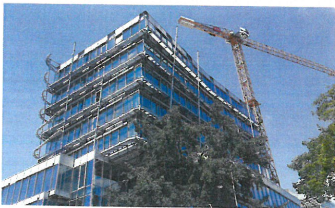
Ocelová konstrukce budovy při montáži fasády ETFE
