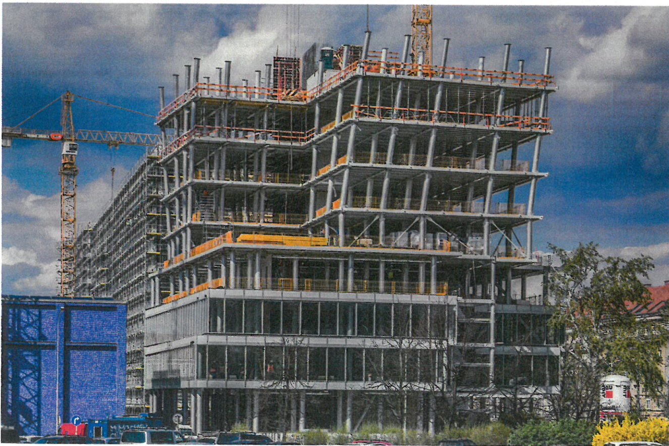
Ocelová konstrukce budovy při výstavbě
