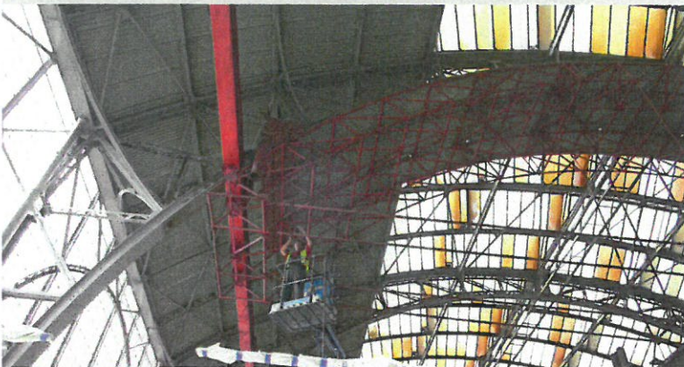
▲ Obr. 23. Posuvná montážní lávka nad IV. nástupištěm
