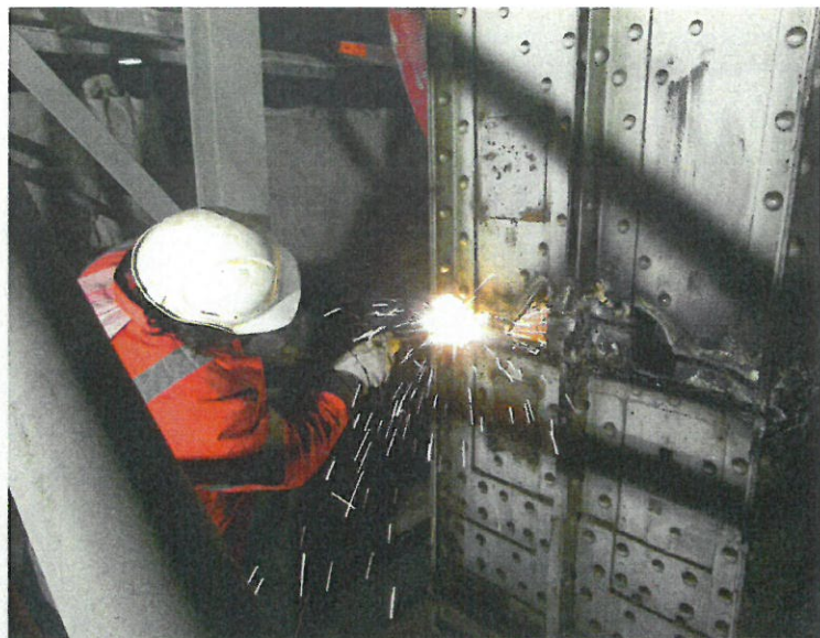
▲ Obr. 16. Demontáž sloupu 1B na III. nástupišti podepřeného provizorní podporou
