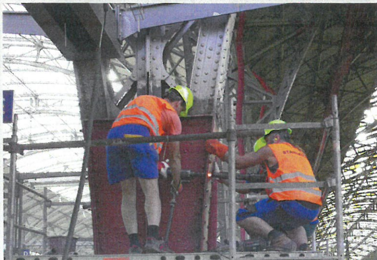
▼ Obr. 19. Nýtování sloupu 1B na III. nástupišti na montáži
