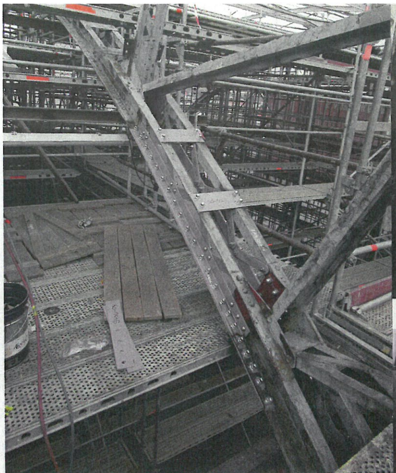
▲ Obr. 8. Spodní pas příčné vazby po opravě
