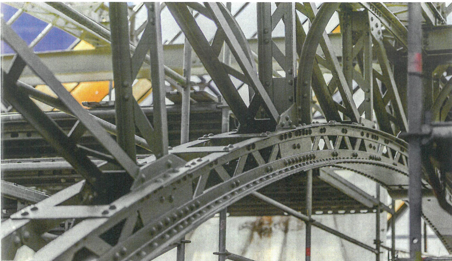
▲ Obr. 28. Pohled na spodní pas vazby 15 nad III. nástupištěm během 6. etapy obnovy (foto: Tomáš Malý)
