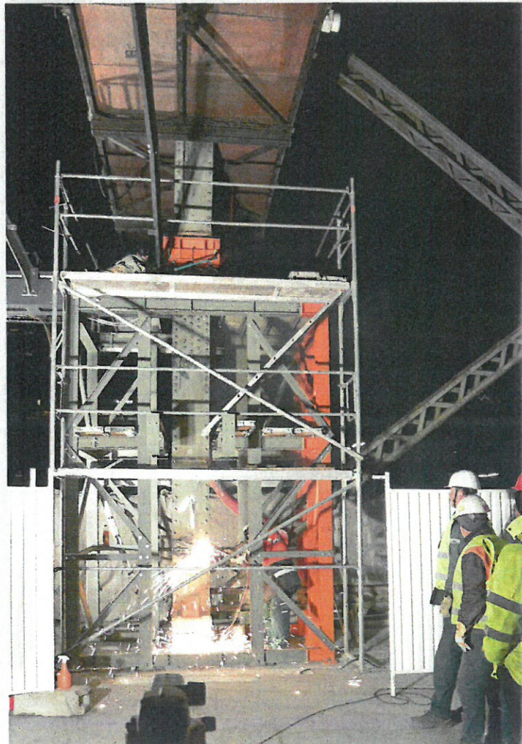
▼ Obr. 14. Demontáž sloupu 1B na III. nástupišti podepřeného provizorní podporou
