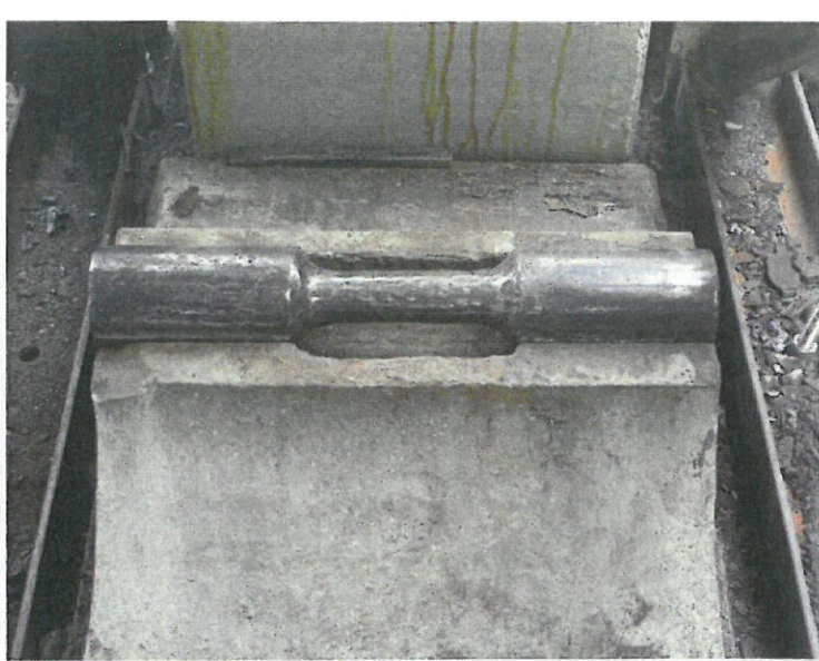
▲ Obr. 12. Kloubové ložisko po očištění s osazeným čepem. Sloup 1C na IV. nástupišti.
