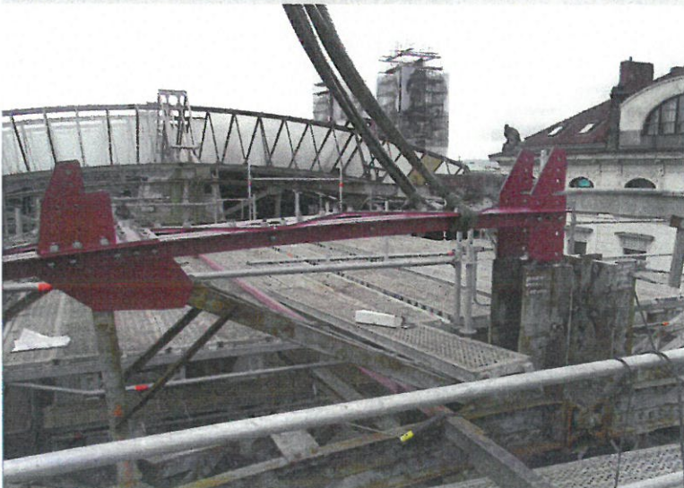
▼ Obr. 26. Montáž nových horních pasů vazníků. Vazba 20 nad III. nástupištěm. Otvory pro připojení diagonál a svislic vazníků byly dovrtány na míru až po usazení pasu, styčnickový plech se pro vrtání dočasně vyjmul ze sestavy pasu.
