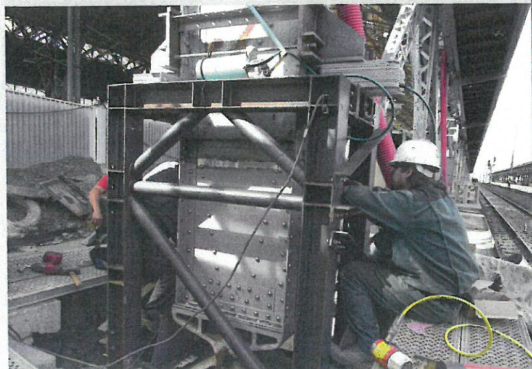
▼ Obr. 10. Montážní sestava nové spodní části sloupu 1C na IV. nástupišti
