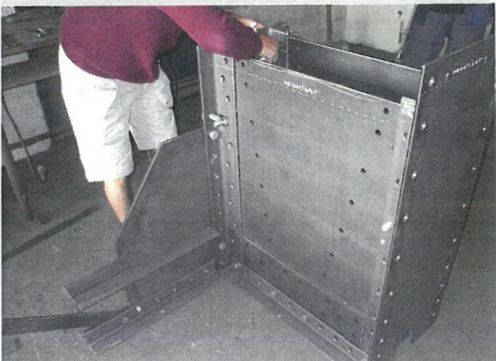
▼ Obr. 9. Dílenská sestava nové spodní části sloupu 1C na IV. nástupišti
