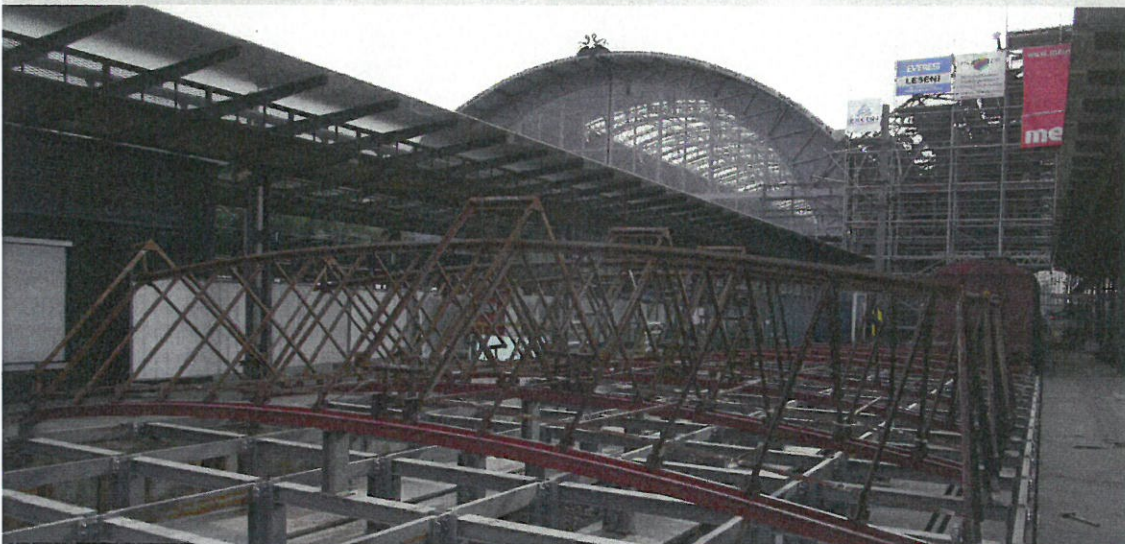
▲ Obr. 25. Uložení světlíků z pole 19 A-B na montážní stůl, kde byly světlíky opraveny, svtány s novými světlíkovými nosníky a natřeny
