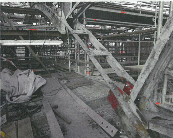
▲ Obr. 7. Spodní pas příčné vazby během opravy
