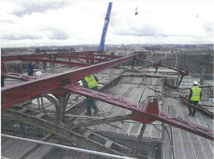
▼ Obr. 27. Montáž nových horních pasů vazníků, vaznic a propojek vaznic. Vazba 20 nad III. nástupištěm.
