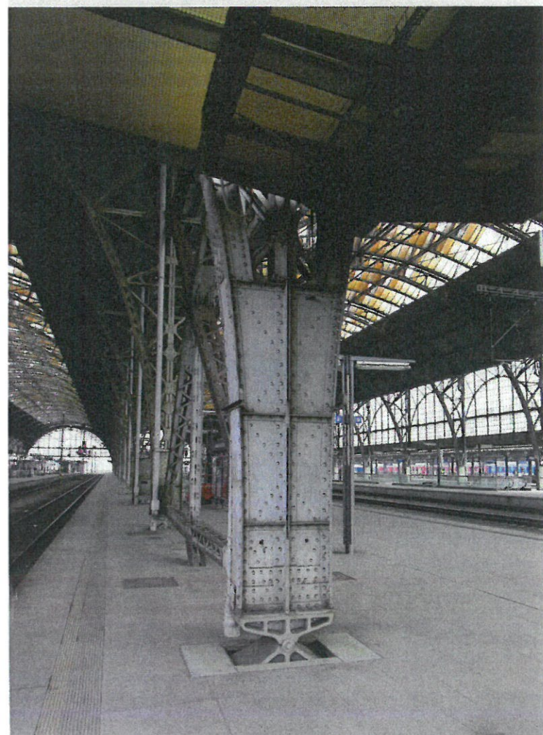
▼ Obr. 13. Sloup 1B na III. nástupišti. Plnostěnná část je vyměněna.
