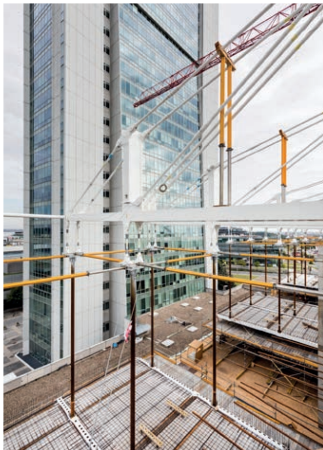
Obr. 21 – Stabilizace závěsných tyčí
