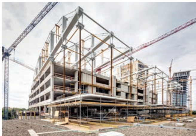
Obr. 23 – Zavěšené ocelové rošty v osách K' a L'
