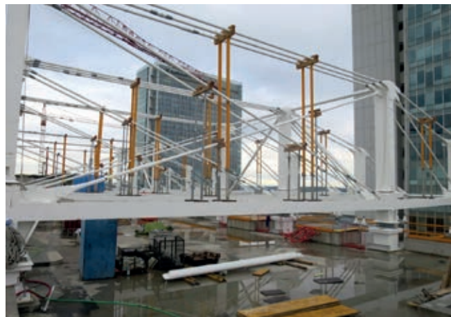
Obr. 25 – Podepření táhel provizorními stojkami
