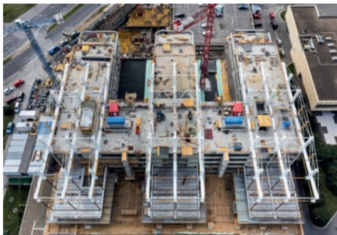
Obr. 22 – Namontovaná ocelová superkonstrukce
