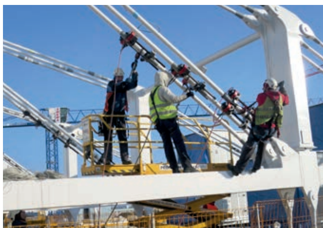
Obr. 27 – Předpínání táhel technotensionery ve třetí etapě (do 1 800 kN)
