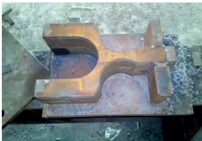
Obr. 10 – Komora pro osazení hydraulických lisů v provizorní podpůrné konstrukci
