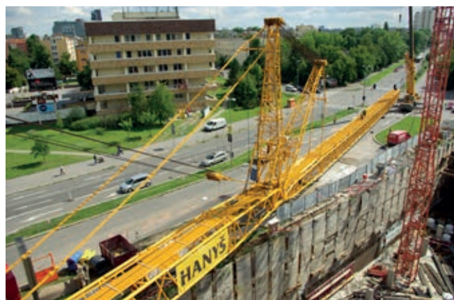
Obr. 14 – Montáž jeřábu LR 1750 reprezentující stav před vztyčením 119 m dlouhého výložníku
