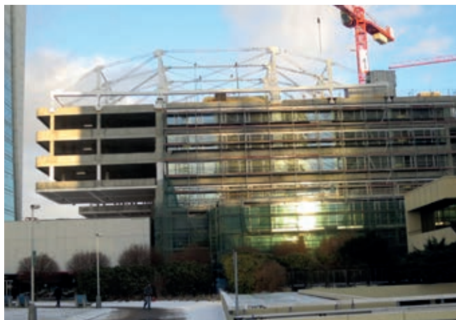
Obr. 26 – Dokončená železobetonová konstrukce zavěšená v osách K' a L'
