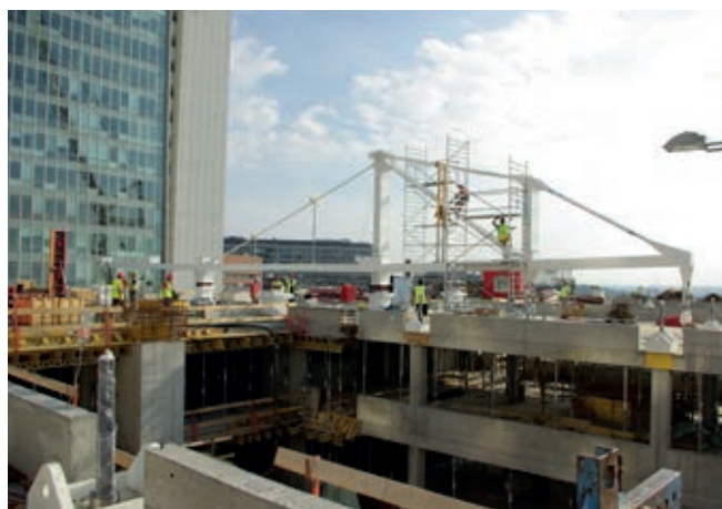
Obr. 18 – Předmontáž vazníku v obrácené poloze
