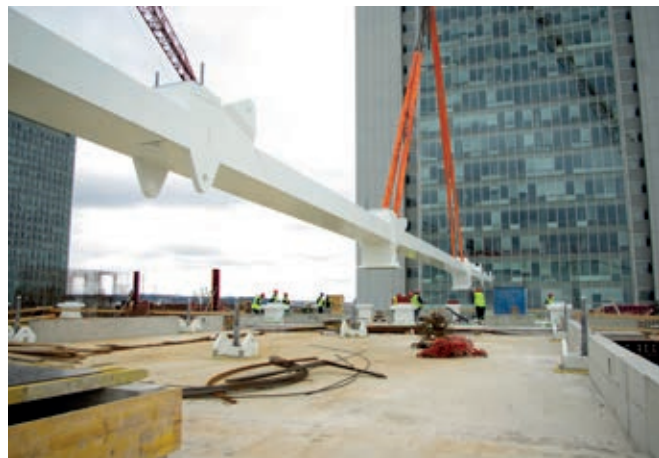
Obr. 16 – Montáž dolního pasu v obrácené poloze
