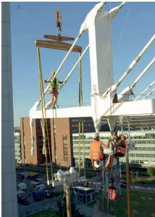
Obr. 20 – Montáž závěsných trubek
