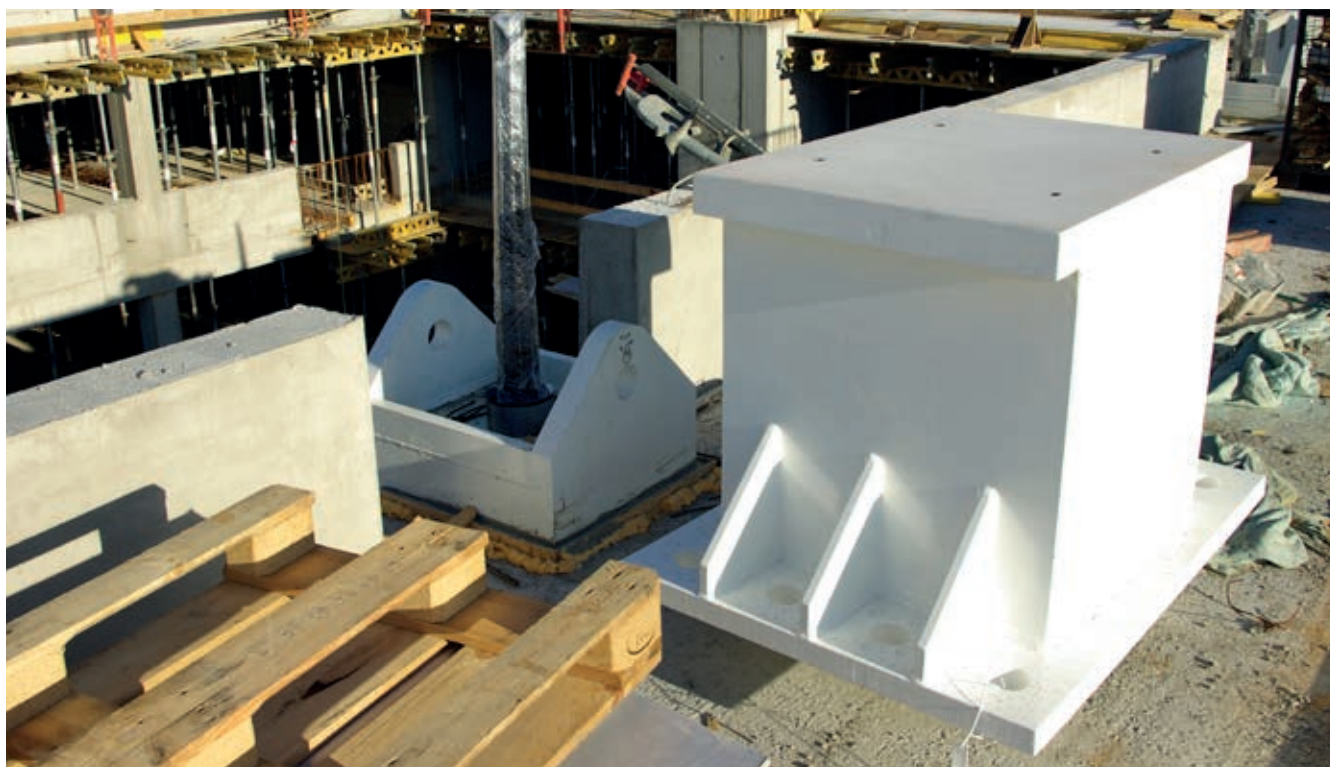
Obr. 12 – Zabetonované převraky v úrovni střechy a kotevní box před osazením
