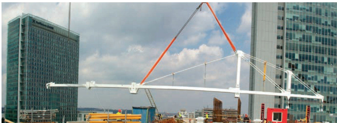
Obr. 19 – Zdvih, otočení a usazení 1. předmontovaného vazníku na osu 1'
