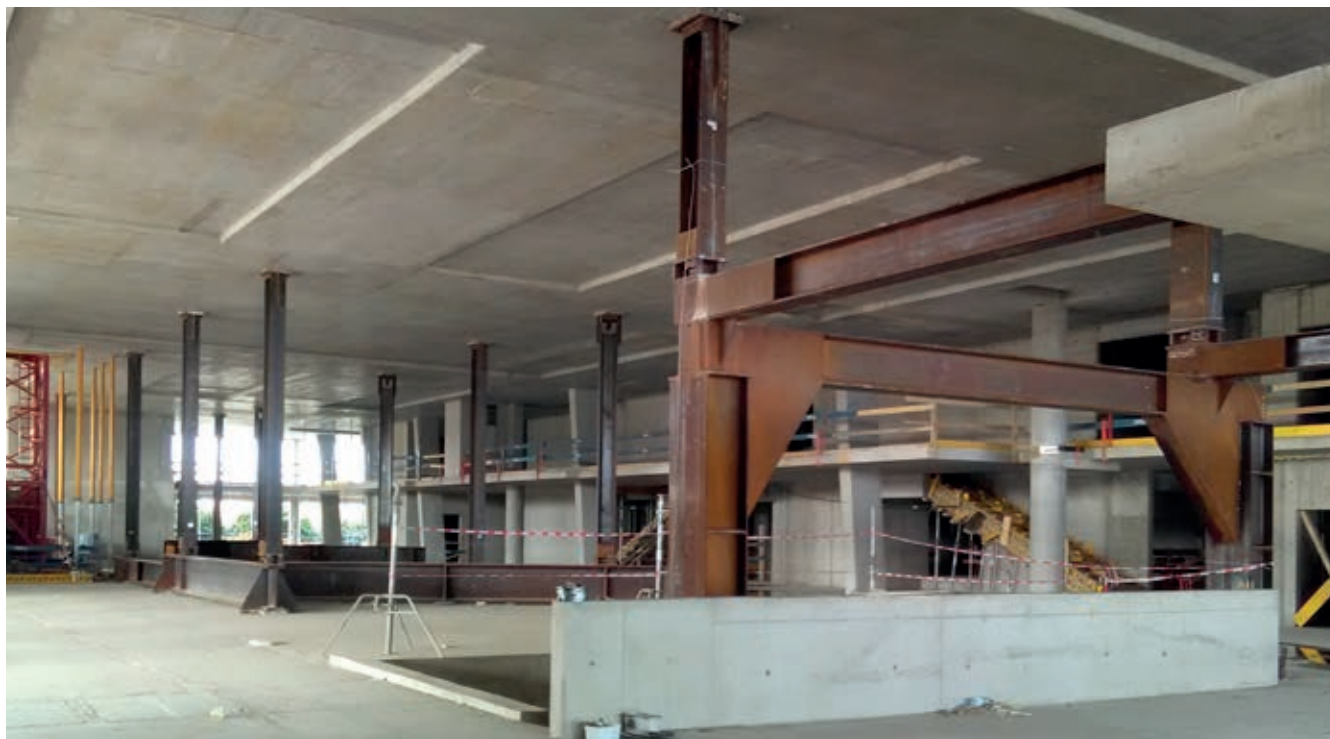
Obr. 9 – Provizorní podpůrná konstrukce po vyzrání betonu a demontáži bednění stropu
