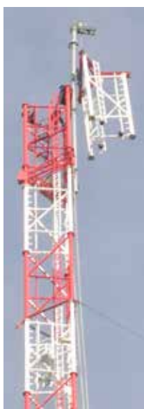
Obr. 19 Montáž dílu stožáru pomůckou
