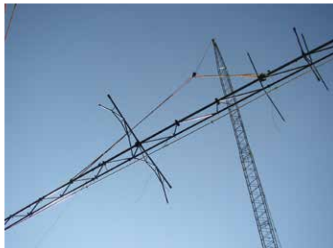
Obr. 8 Montáž vazníků jednotlivě
