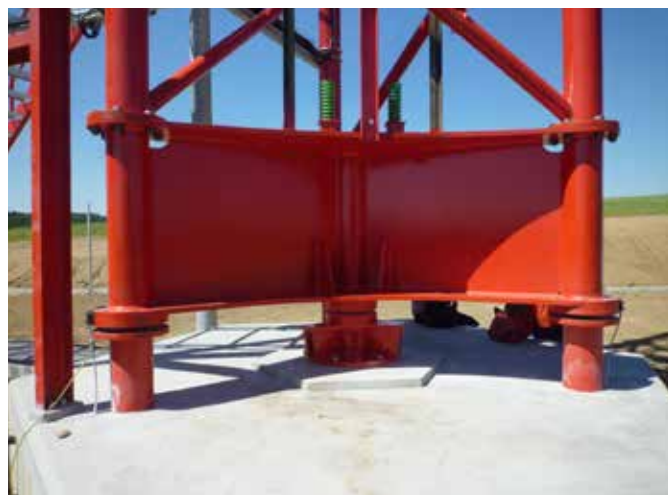
Obr. 21 Patní díl, kloub s torzním vetknutím
