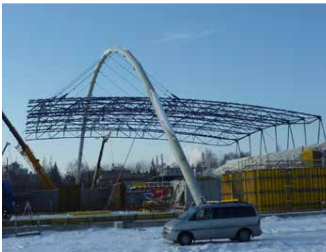
Obr. 27 Asymetrická montáž střešní konstrukce
