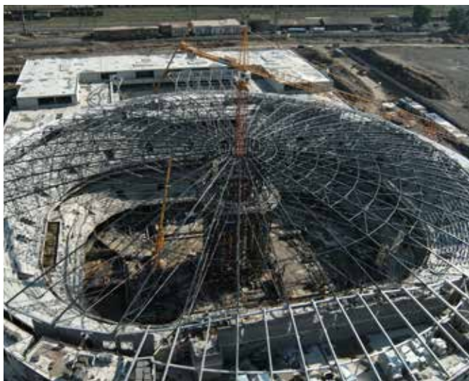
Obr. 2 Zastřešení Sazka (O 2 ) areny ve tvaru kulového vrchlíku
