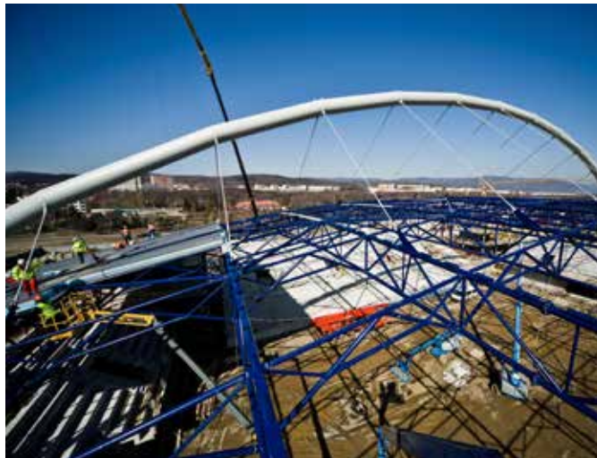
Obr. 26 Konstrukce střechy zavěšená na oblouku
