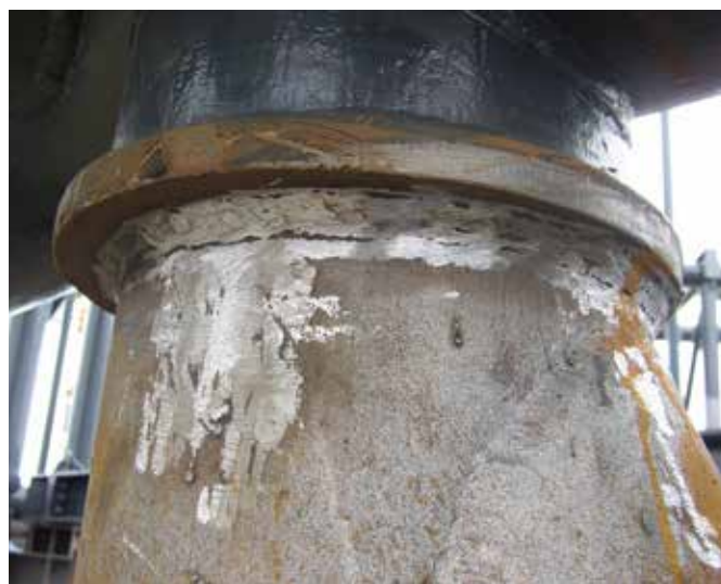
Obr. 5 Montážní spoj svislic středního válce
