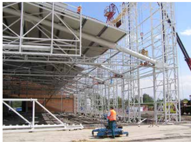
Obr. 15 Střecha hangáru při zdvihu
