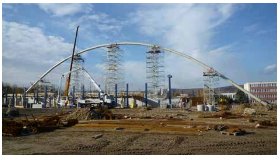
Obr. 23 Montáž oblouku na provizorních podporách
