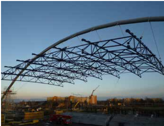
Obr. 25 Zavěšení střední části příhradové konstrukce
