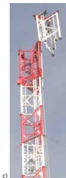
Obr. 17 Příhradové těleso stožáru
