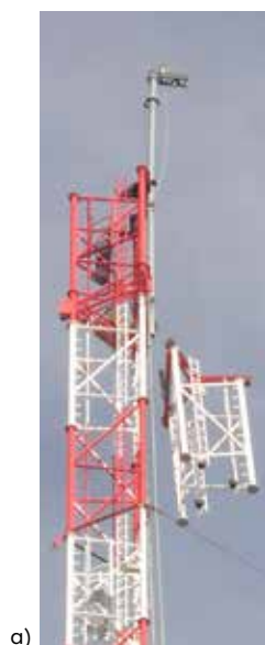
Obr. 19 Montáž dílu stožáru pomůckou
