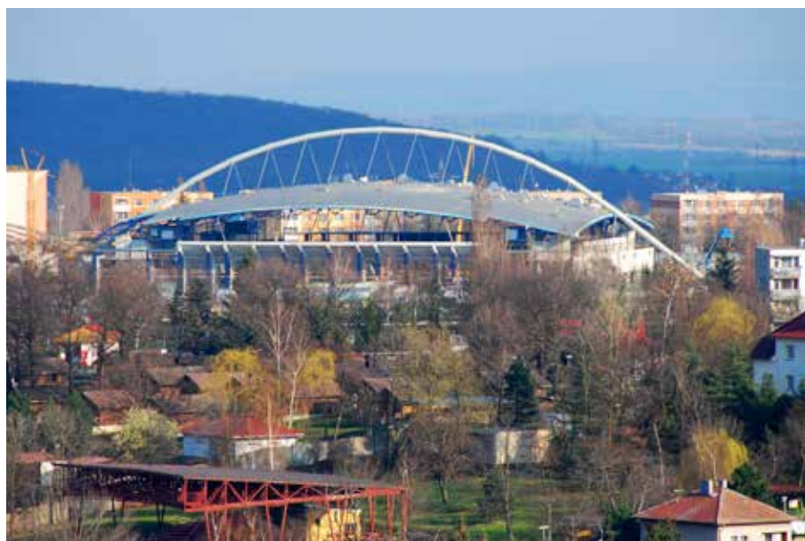
Obr. 24 Konstrukce po zakrytí střešním pláštěm
