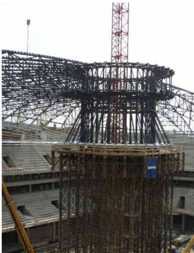
Obr. 9 Konstrukce na pížmu po montáži dvaceti vazníků
