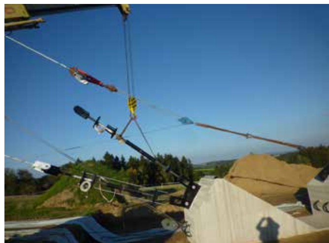
Obr. 20 Montáž lana do napínacího zařízení
