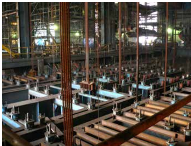
Obr. 32 Nosný rošt 2. tahu a mezitahu stávajícího kotle při spouštění
