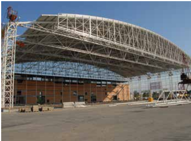
Obr. 10 Konstrukce střechy hangáru po zdvihu
