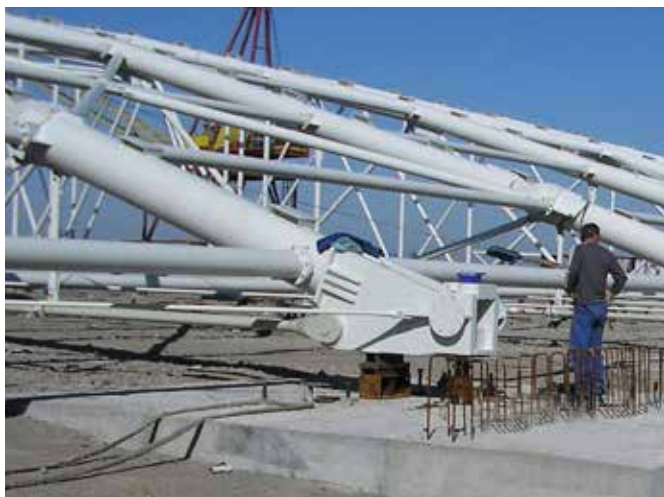
Obr. 14 Zdvih konce vazníku hydraulickými lisami
