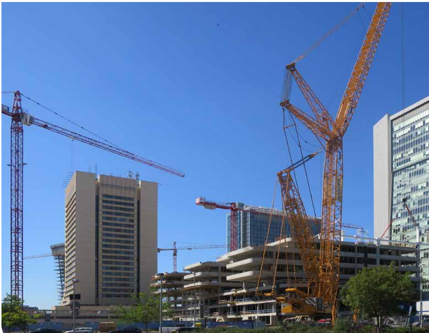
Obr. 1 Největší pásový jeřáb v ČR při montáži ocelové střešní superkonstrukce na stavbě City Deco, Praha (Trimaran)
