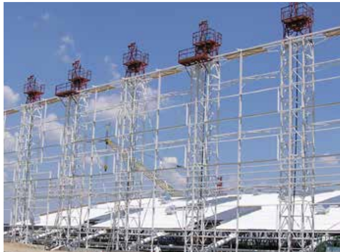
Obr. 11 Hydraulické jednotky na vrcholech sloupů před zdvihem střechy
