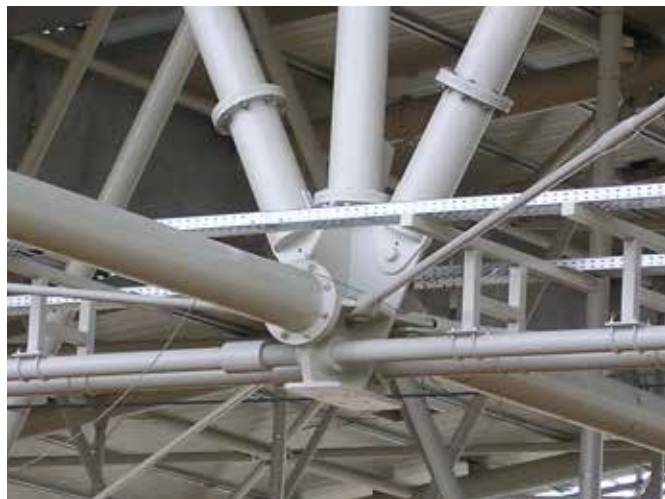
Obr. 13 Styk spodního pasu vazníku (dvě táhla M105) s diagonálami, svislicí a příčným ztužením
