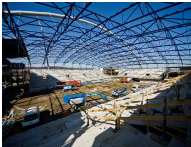
Obr. 28 Konstrukce střechy po montáži
