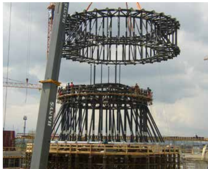
Obr. 3 Montáž středního válce ze dvou částí
