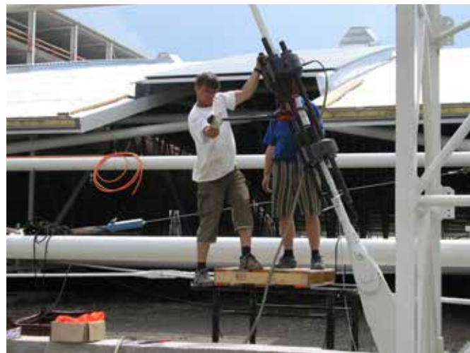
Obr. 12 Napínání stěnové diagonály
