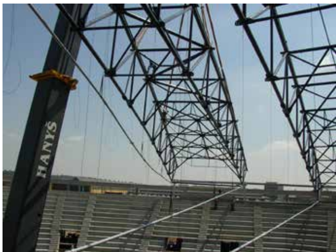
Obr. 7 Montáž vazníků a táhel po dvojicích
