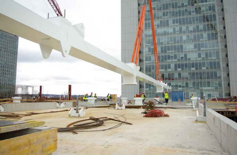
▲ Obr. 15 Montáž dolního pasu v obrácené poloze
