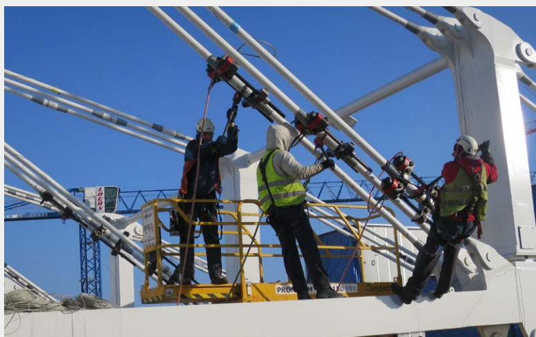
▼ Obr. 25 Předpínání táhel technotensionery ve třetí etapě (do 1800 kN)
