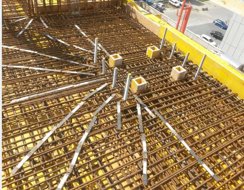
▲ Obr. 8 Příprava pro kotevní bod kotevního boxu
