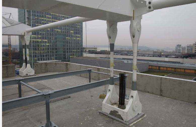
▲ Obr. 21 Přeprava s předpínací výztuží a závěsy M85
