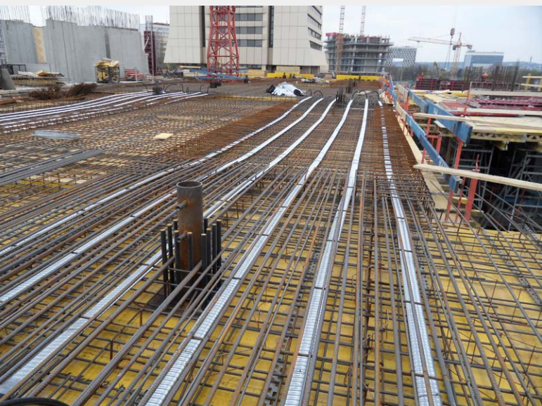
▼ Obr. 5 Kotevní desky se zárodky trubek, závitovými tyčemi a trasovanými kabely VSL
