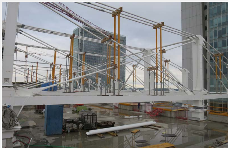
▲ Obr. 23 Podepření táhel provizorními stojkami
