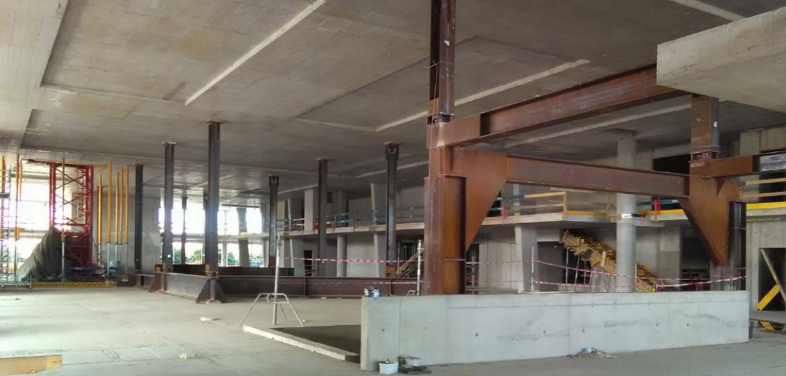
▲ Obr. 4 Provisorní podpůrná konstrukce po vyzrání betonu a demontáži bednění stropu
