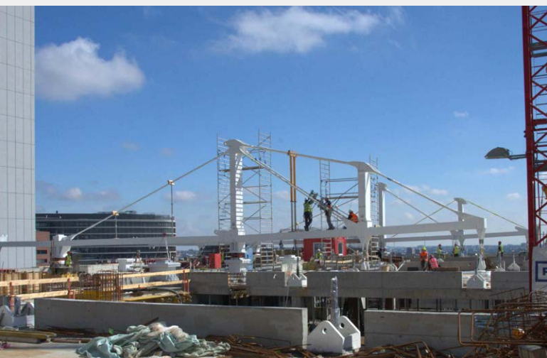
▲ Obr. 16 Předmontáž vazníku montovaného v obrácené poloze
