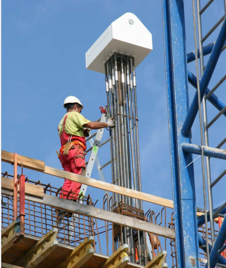
▲ Obr. 7 Osazení přepravy se závitovými spojkami výztuže
