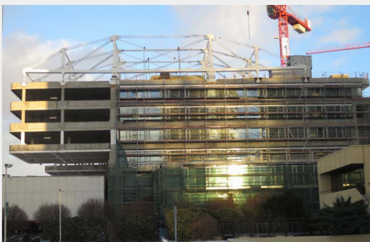
▼ Obr. 24 Dokončená železobetonová konstrukce zavěšená v osách K, L
