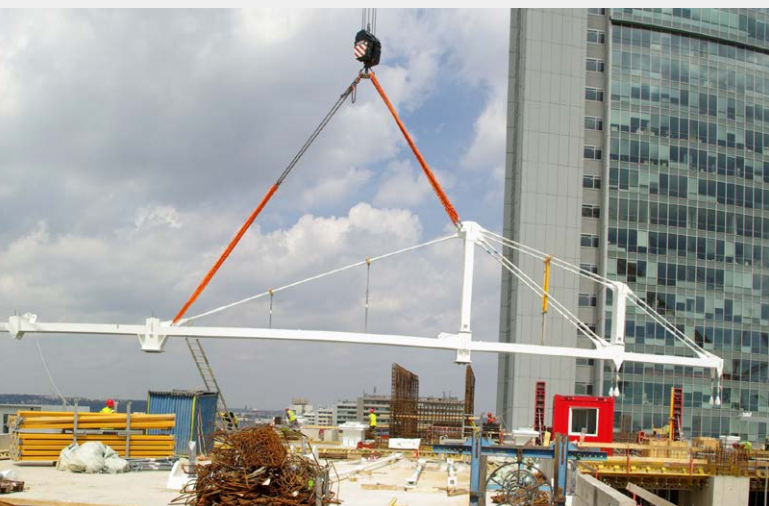
▲ Obr. 17 Zdvih, otočení a usazení 1. vazníku na osu 1
