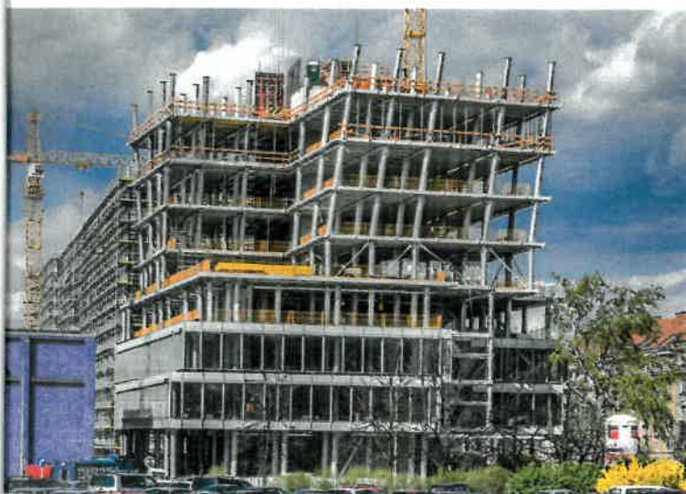
Realizace projektu CIIRC. Od pátého patra jsou jednotlivá podlaží včetně sloupů pootočená o 1,5°, díky čemuž jsou sloupy v těchto podlažích šikmé.
