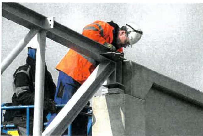
Usazení ocelového rámu do nosné prefabrikované konstrukce Letištního terminálu v Pardubicích.
