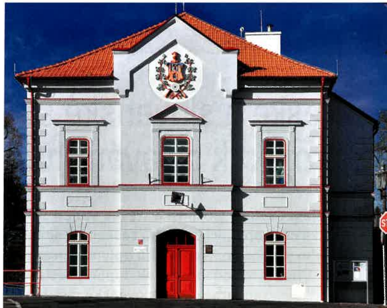
▲ Snížení energetické náročnosti budov Domu dětí a mládeže v Českém Krumlově, Linecká 67
