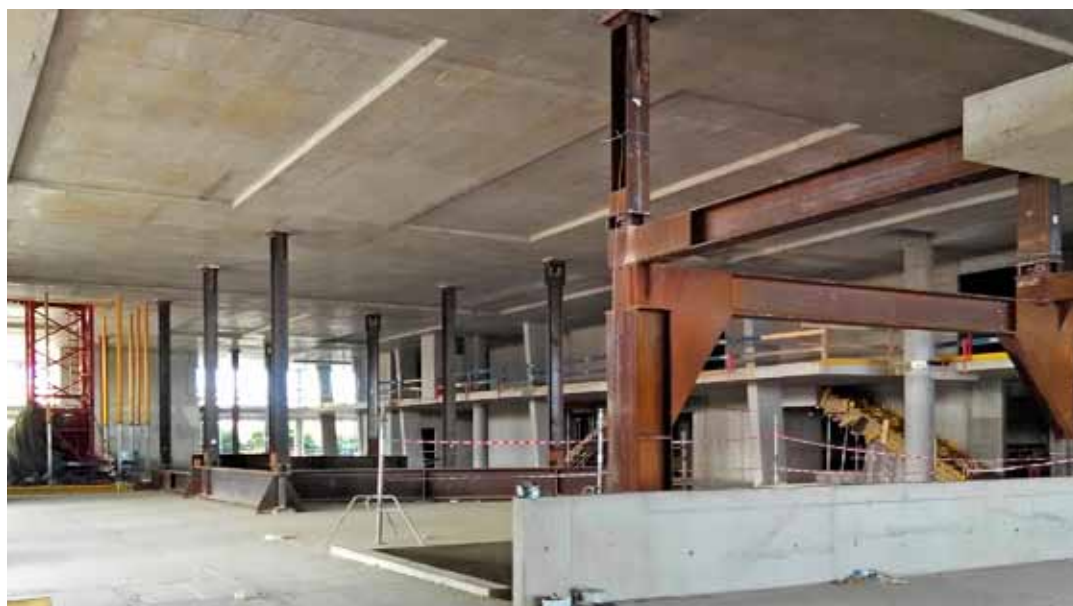
Obr. 8: Dočasná ocelová konstrukce ve 2. NP (konferenční sál)
