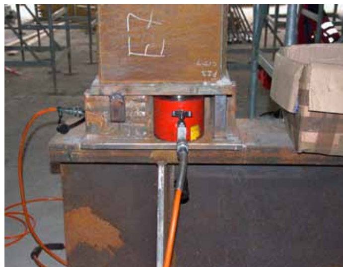
Obr. 7: Zdvhací lisy pod dočasným sloupem
