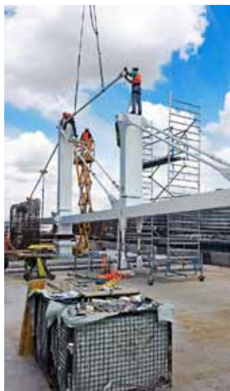
Obr. 15, 16: Osazování táhel na vazníky
