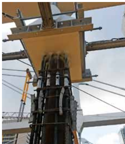
Obr. 13: Napojení výztuže u sloupu na konzole
