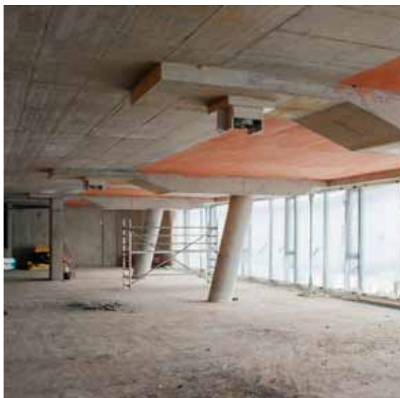
Obr. 10: Kotevní body, trámy a šikmé sloupy ve 2. NP
