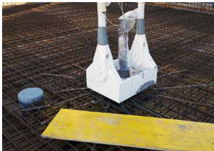
Obr. 12: Výztuž pod kotevním bodem na ose K
