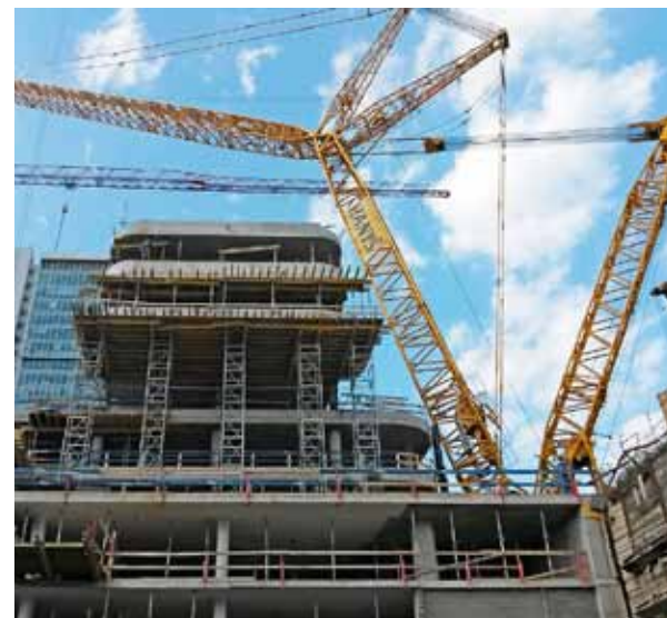
Obr. 17: Jižní konzoly s jeřábem
