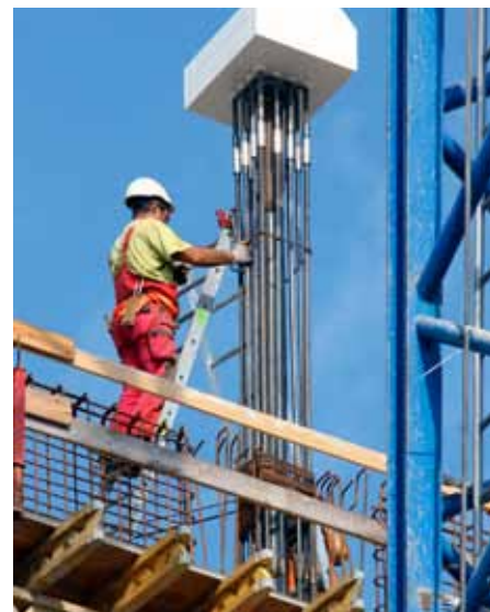
Obr. 11: Výztuž sloupu 6. NP s přepravkou
