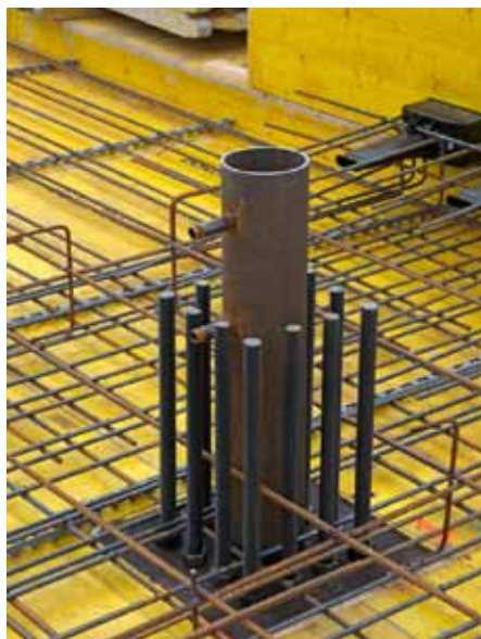
Obr. 3: Kotevní bod sloupu nad 2. NP
