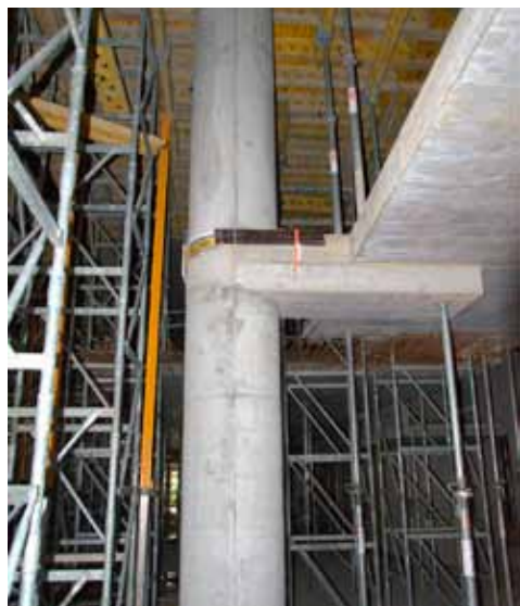
Obr. 9: Napojení sloupu mimo desku
