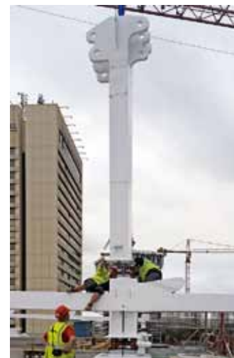
Obr. 14: Osazování svislice vazníku
