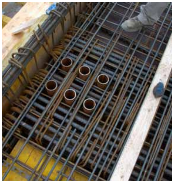
Obr. 4: Výztuž trámu nad 2. NP s prostupy pro ukotvení táhel M42
