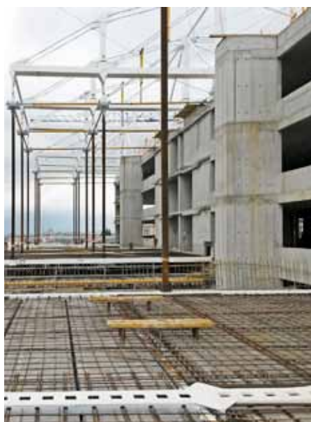
Obr. 22: Dutinové panely s výztuží a ocelovým roštem
