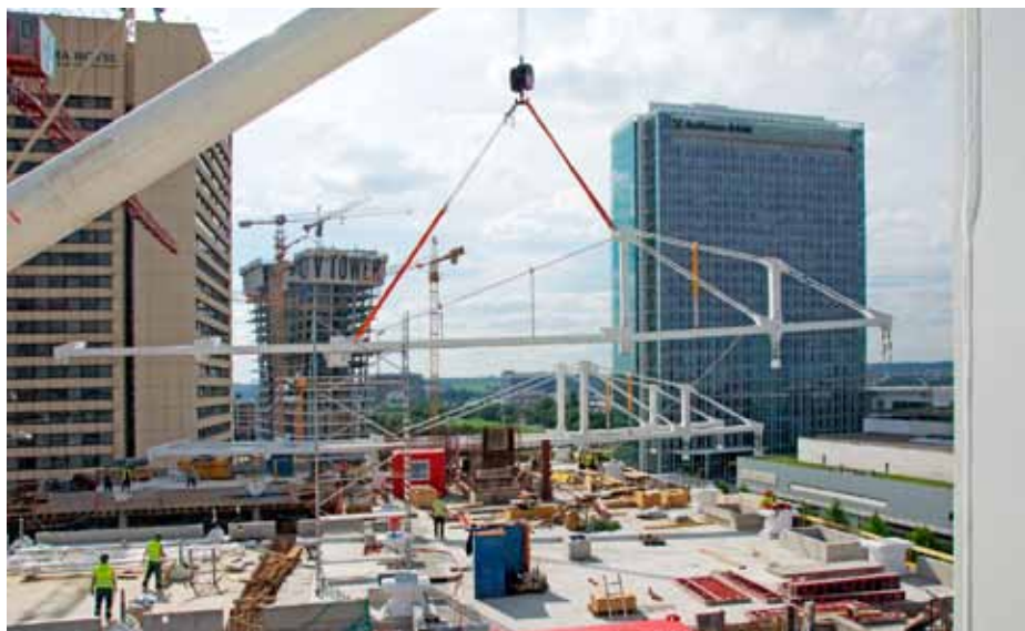
Obr. 20: Otáčení vazníku
