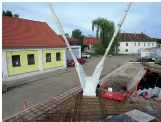
Kotvení táhel lávka pravá zavěšená
