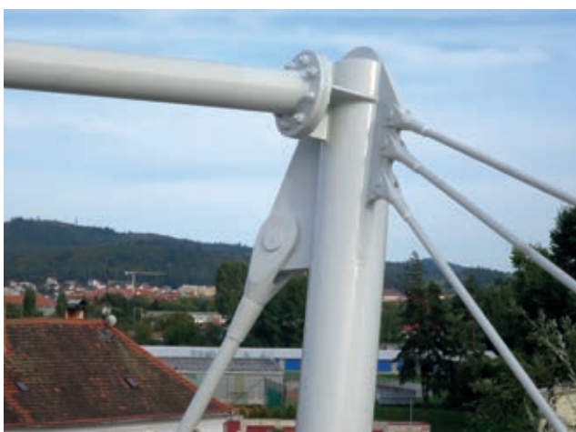
Kotvení uzel lávka levá zavěšená
