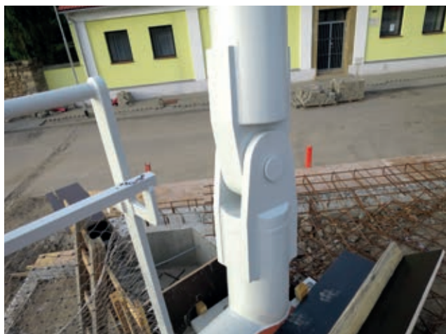
Kloubové spojení pylonu s lávkou
