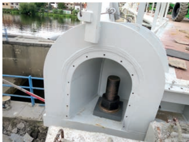
Kotevní šroub lávka pravá – visutá
