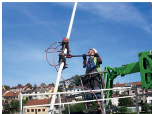
Napínací zařízení technotensioner lávka pravá – visutá
