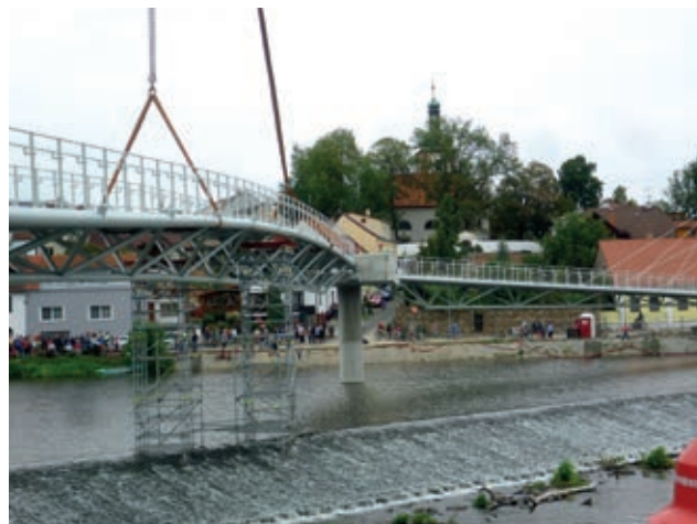
Provizorní podpora lávky pravé na jezu při montáži
