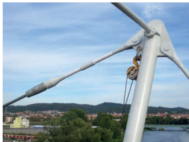
Kotvení lana do pylonu a kotvení provizorních lan M12
