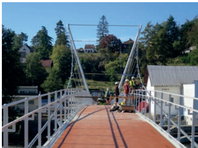
Spojení lan stripů a montáž závěsů
