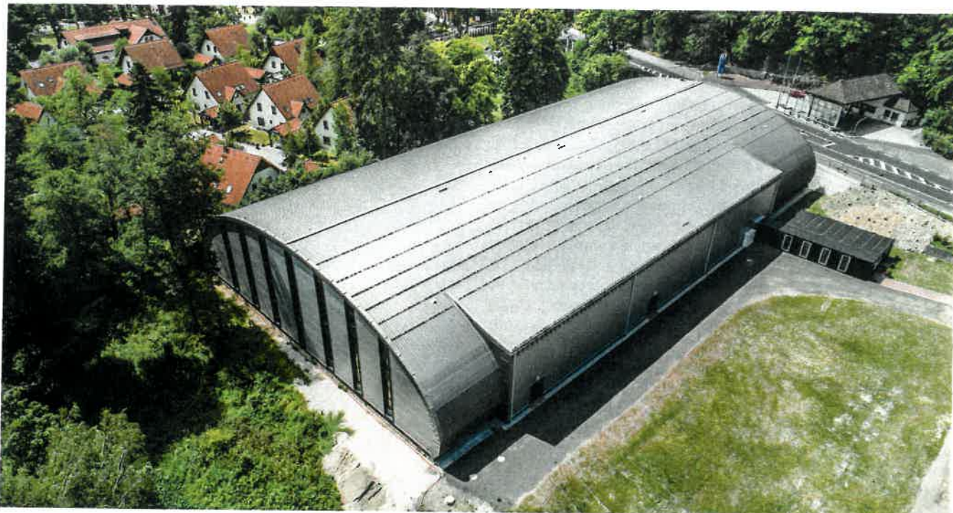
Obr. 5 – Objekt haly s dokončeným opláštěním
