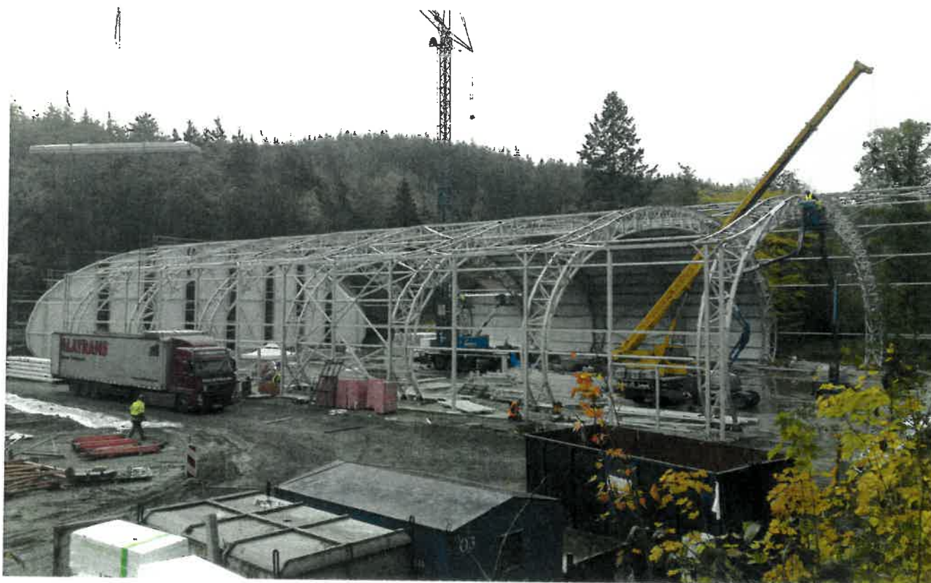
Obr. 4 – Montáž ocelové konstrukce a střešních panelů
