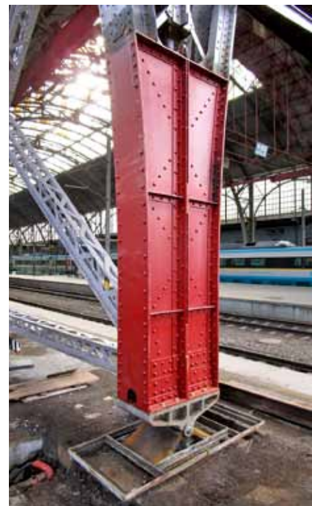
Obr. 22: Sloup po dokončení oprav
