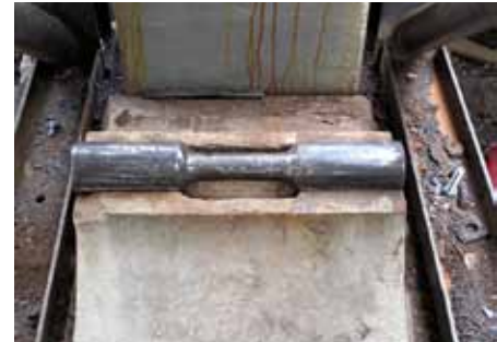
Obr. 16: Kloubové ložisko po očištění s osazeným čepem
