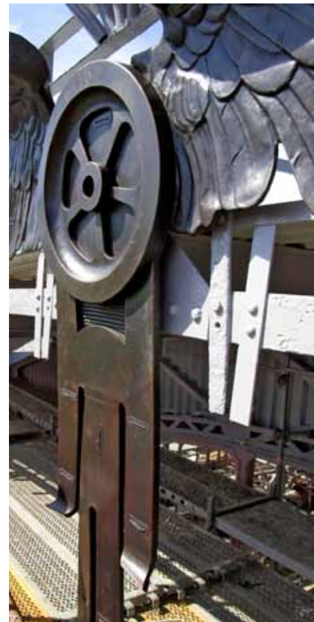
Obr. 33: Reliéfy po restaurování a zpětné montáži do pozice
