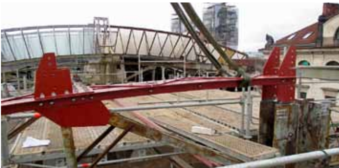
Obr. 31: Montáž nových horních pasů vazníků, otvory pro připojení diagonál a svislé vazníky byly dovtárány na míru až po usazení pasu, styčnický plech se pro vrtání dočasně vyjmul ze sestavy pasu
