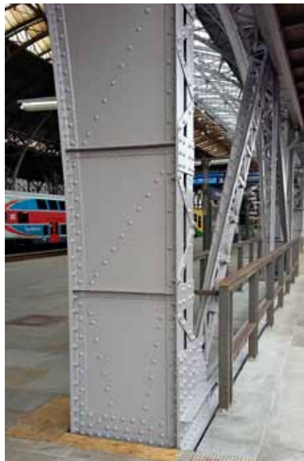
Obr. 17: Sloup 1C po dokončení oprav
