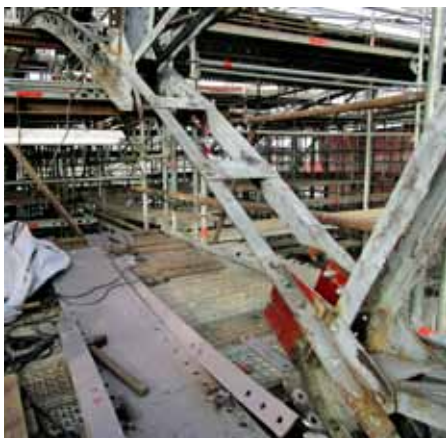
Obr. 9: Spodní pas příčné vazby během opravy
