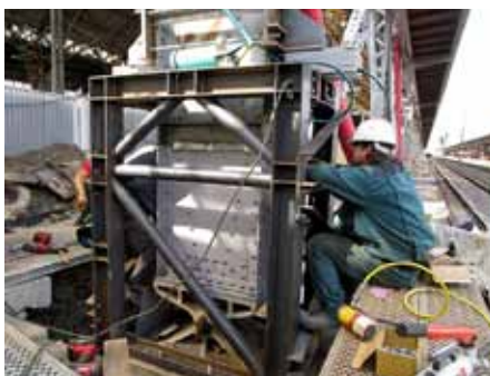
Obr. 14: Montážní sestava nové spodní části sloupu
