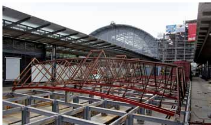
Obr. 28: Uložení světlíků na montážní stůl, kde byly opraveny, svertány s novými světlíkovými nosníky a natřeny
