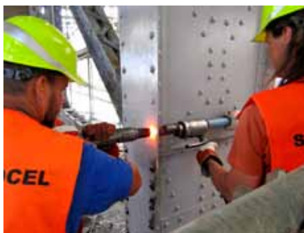
Obr. 21: Nýtování na montáži
