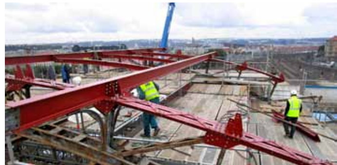
Obr. 32: Montáž nových horních pasů vazníků, vaznic a propojek vaznic
