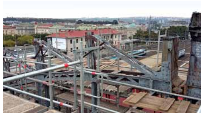
Obr. 30: Příhradové vazníky oblouků po demontáži horních pasů
