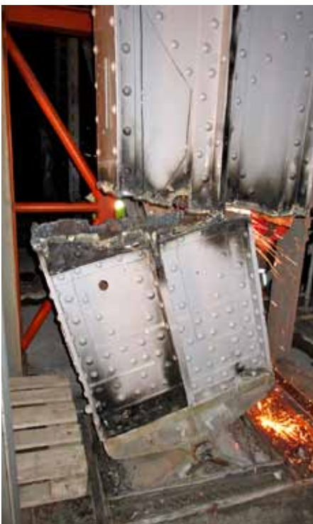
Obr. 19: Demontáž sloupu
