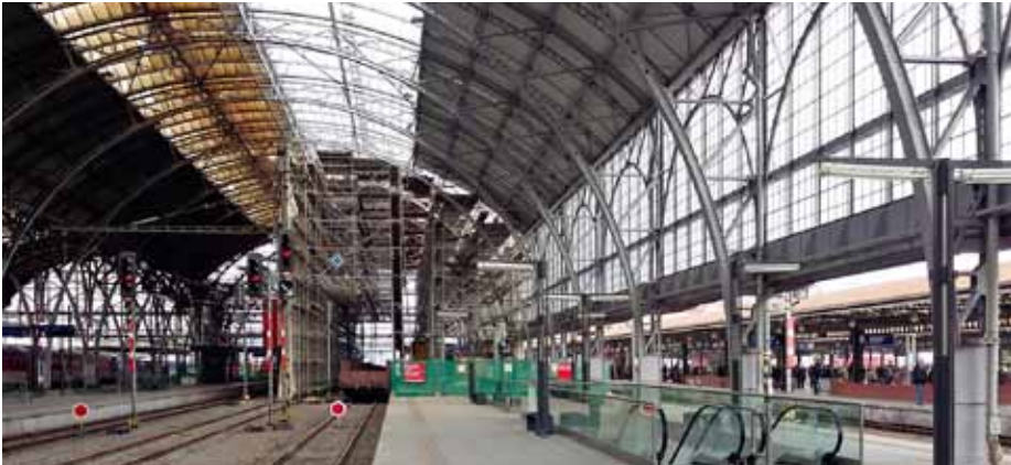
Obr. 2: Prostorové lešení pro 3. etapu obnovy konstrukce
