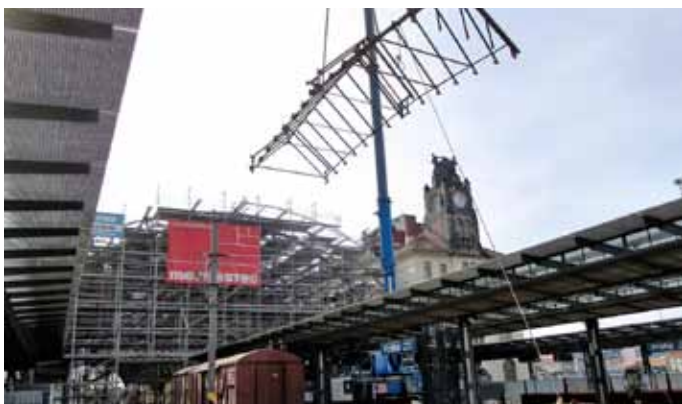
Obr. 27: Demontáž světlíků
