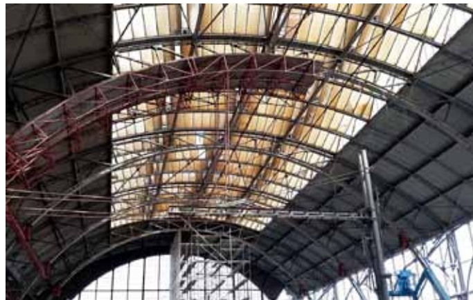
Obr. 26: Stav po demontáži poloviny rozpětí lávky
