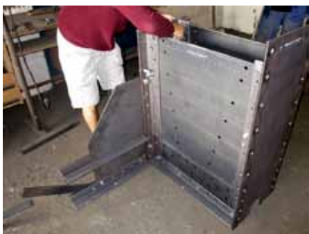
Obr. 13: Dilenská sestava nové spodní části sloupu
