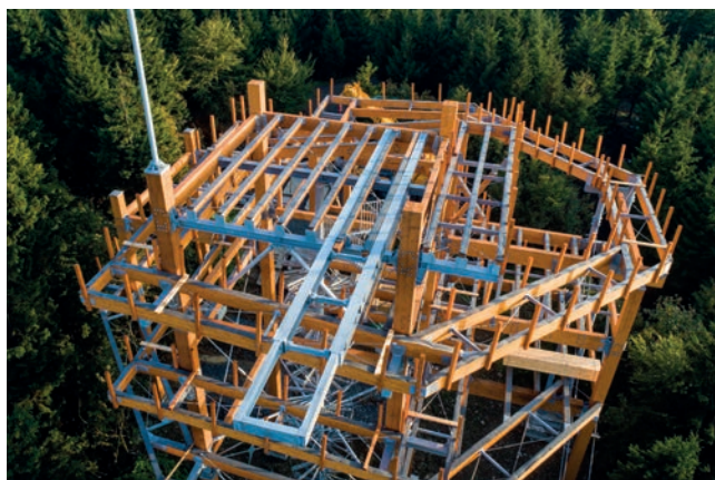
Ocelová konstrukce skywalku (foto: Denis Pagáč)
