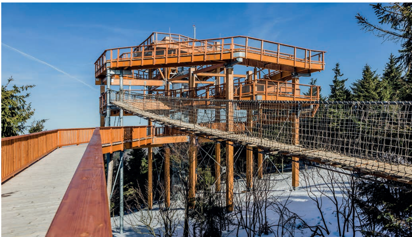
Pohled na věž se vstupem do zpětného lanového chodníku (foto: Tomáš Malý)
