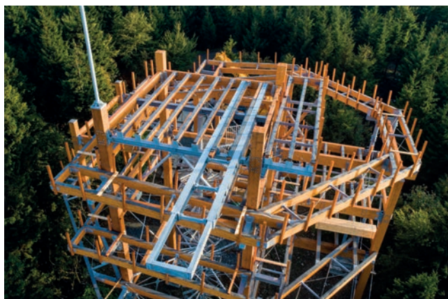
Ocelová konstrukce skywalku (foto: Denis Pagáč)
