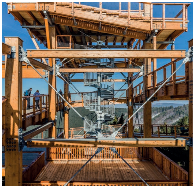
Konstrukce věže z lepeného lamelového dřeva (foto: Tomáš Malý)
