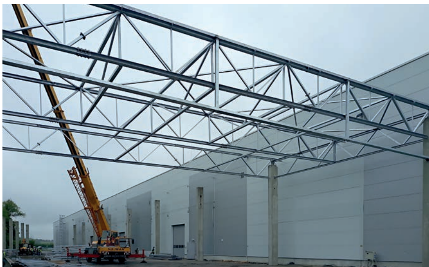
Snímek z montáže konstrukcí pro halu v Kosmonosích
