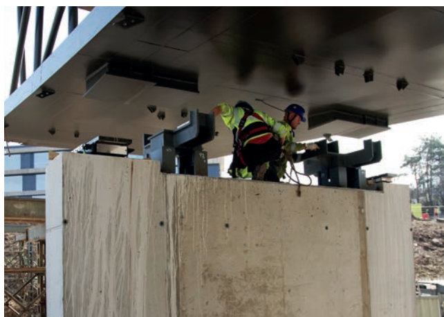
Provizorní rektifikovatelné uložení na pilíři P3
