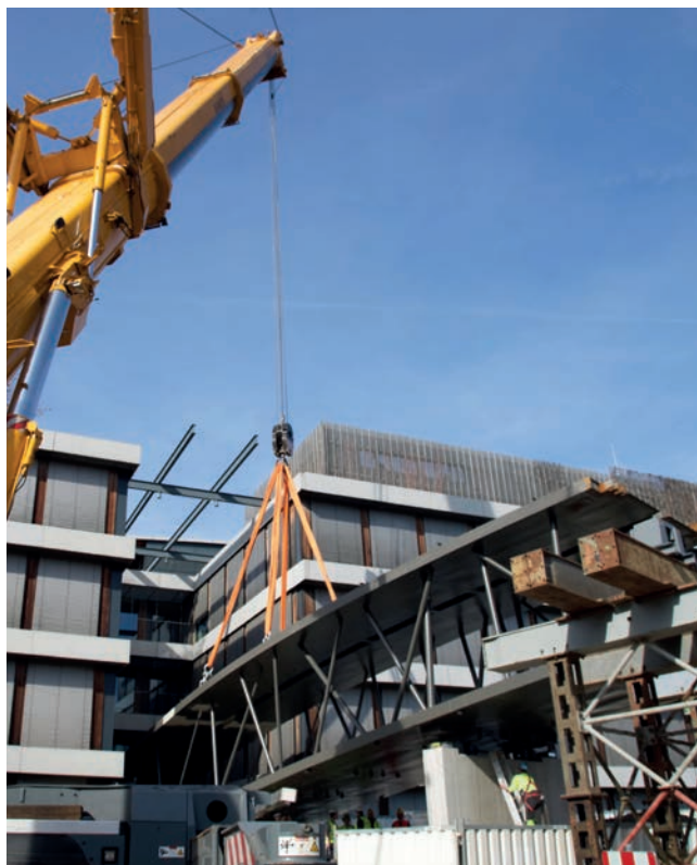
Montáž krajního dílu MD34 pomocí kolového jeřábu LTM1500
