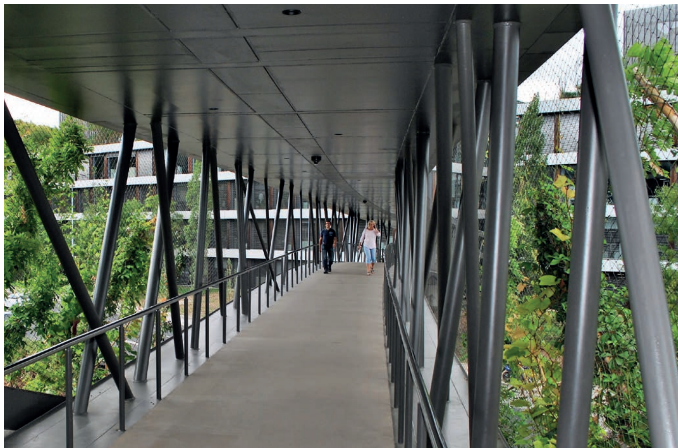
Lávka z pohledu chodce
