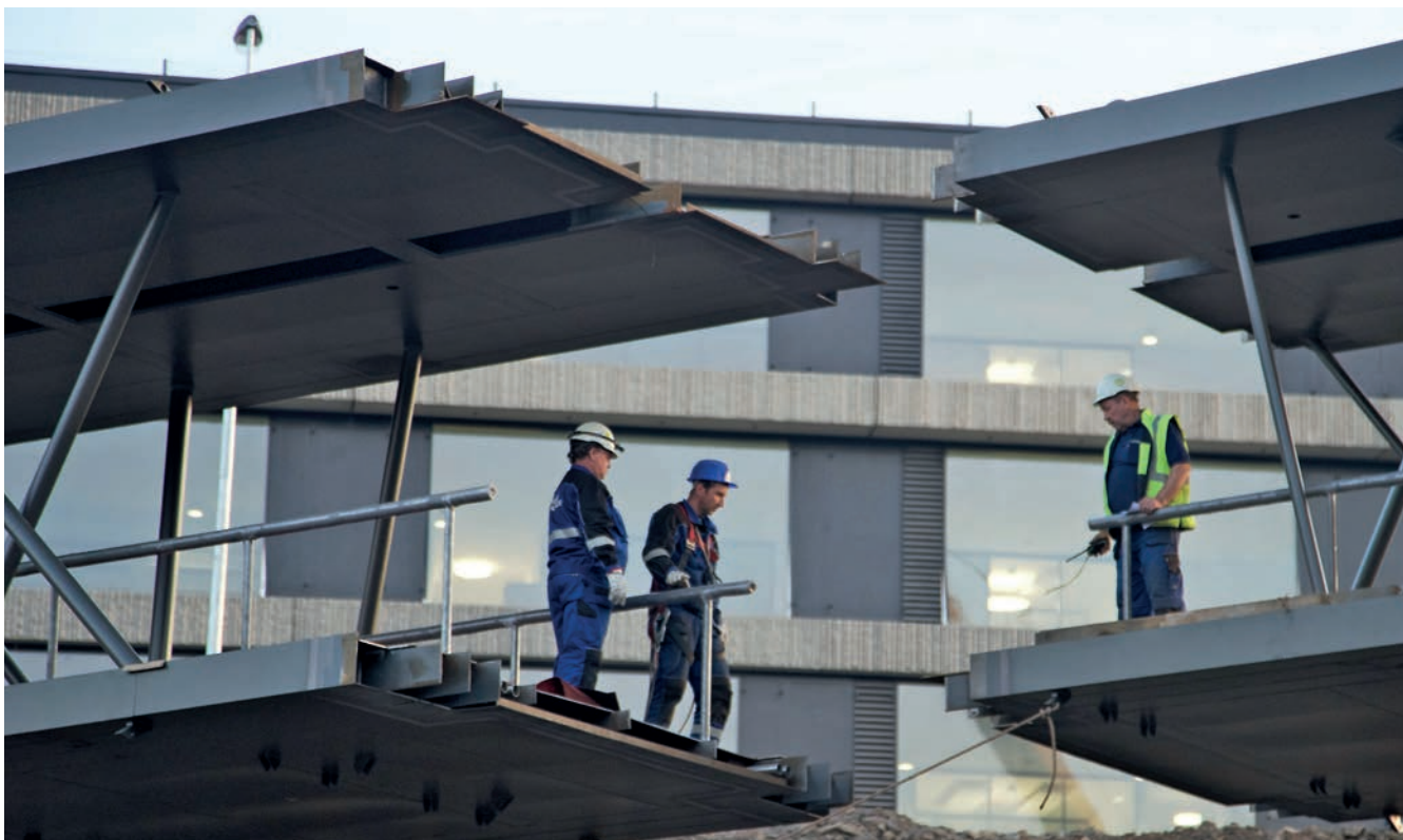
Okamžiky napětí před spasováním dílů MD2 a MD3 na montáži
