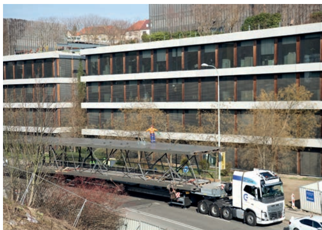
Doprava středního montážního dílu MD2 na místo
