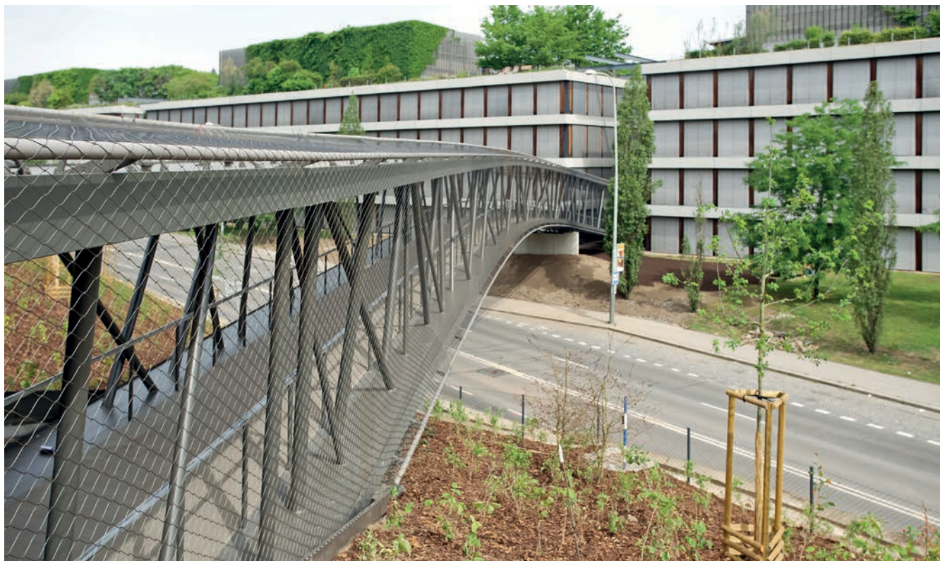
Nerezová síť jako ochrana proti pádu osob a opora pro vedení popínavé zeleně
