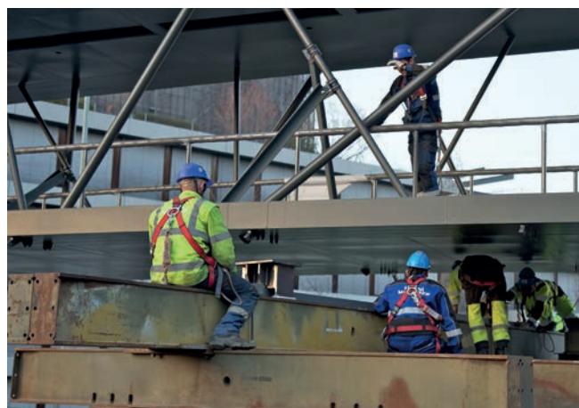
Uložení montážního dílu MD2 na provizorní bárku
