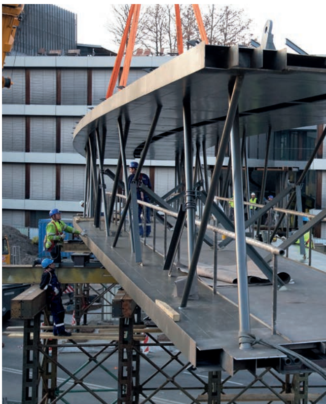
Pohled na tvarově komplikovaný montážní styk MD1-MD2
