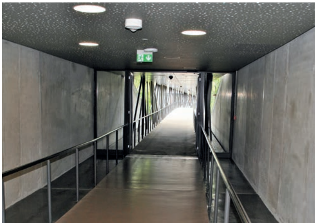
Lávka navazuje na vstup do nové budovy banky
