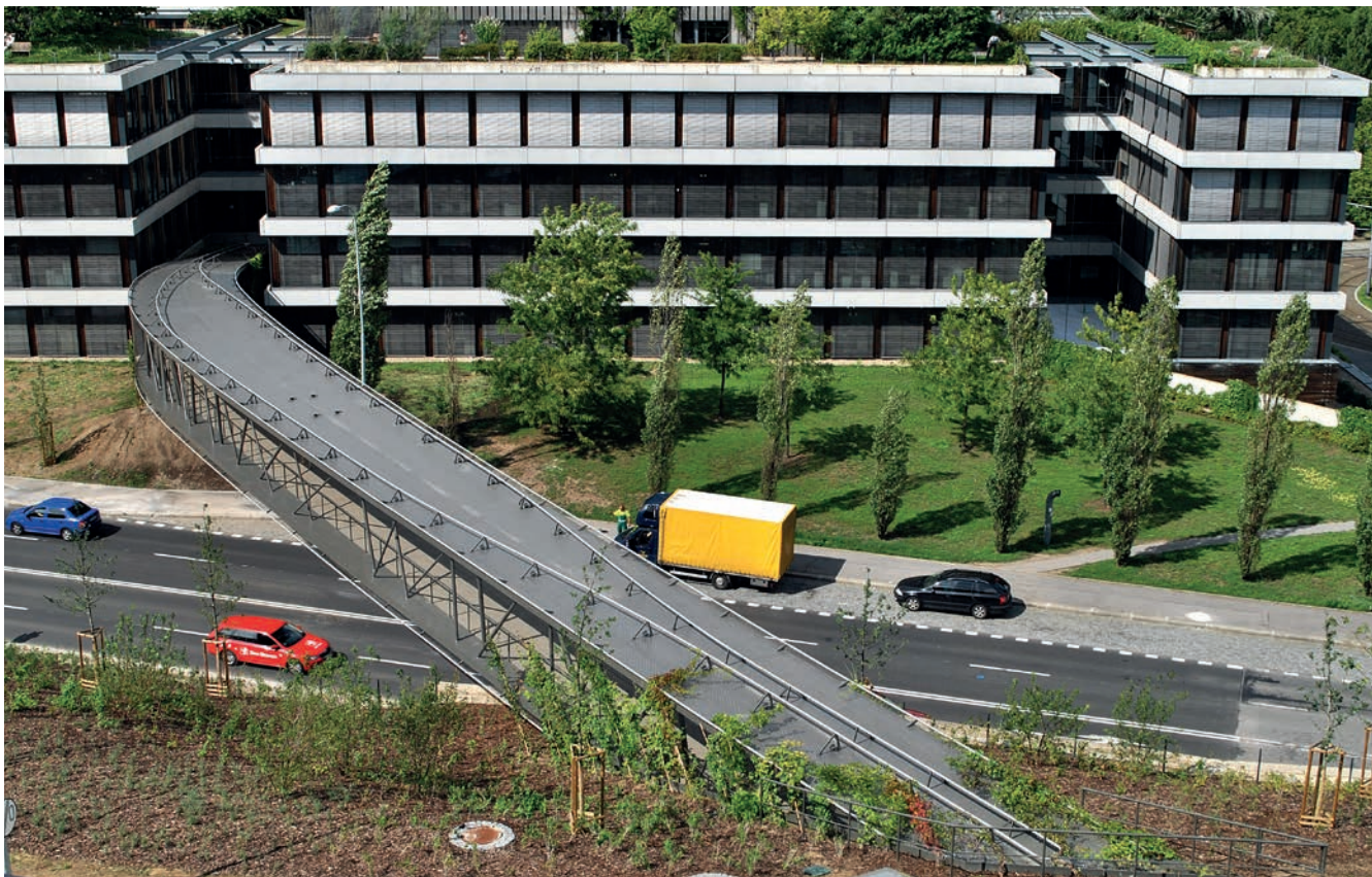
Lávka propojuje obě budovy banky. Pohled ze střechy nového objektu.
