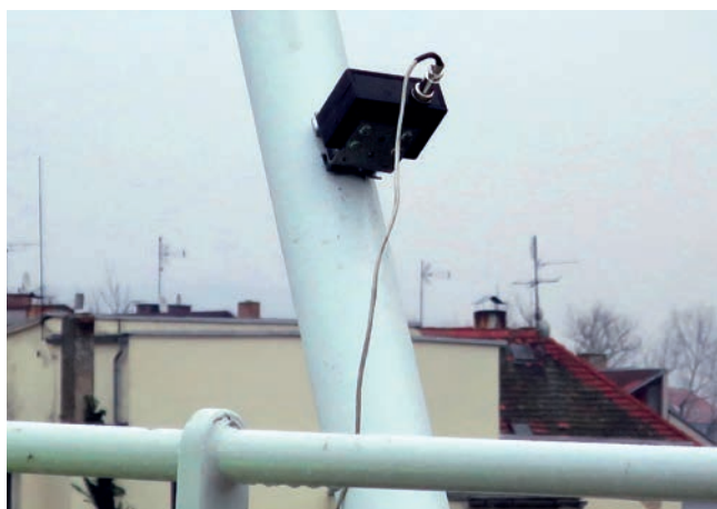
Akcelerometr při frekvenčním měření táhla (lávka Písek)
