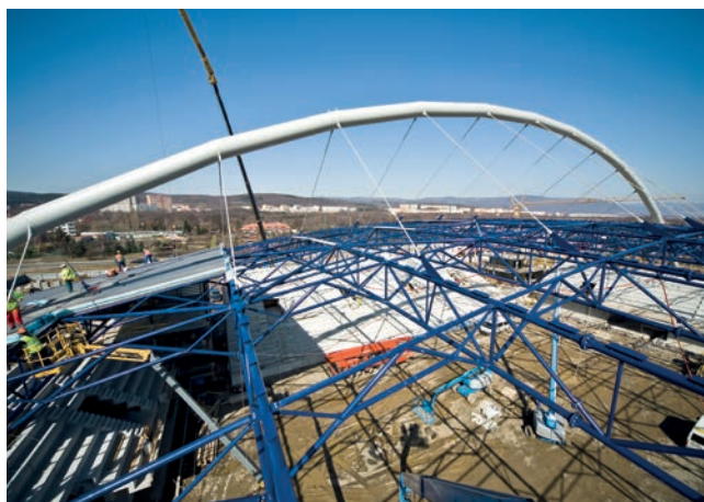
Střešní konstrukce v Chomutově zavěšená na oblouku
