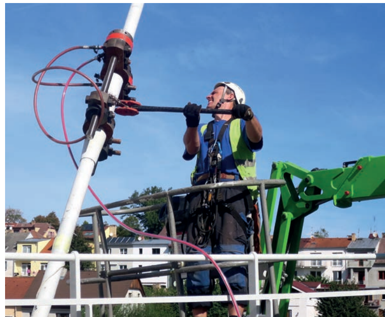
Hydraulické předpínání táhel
