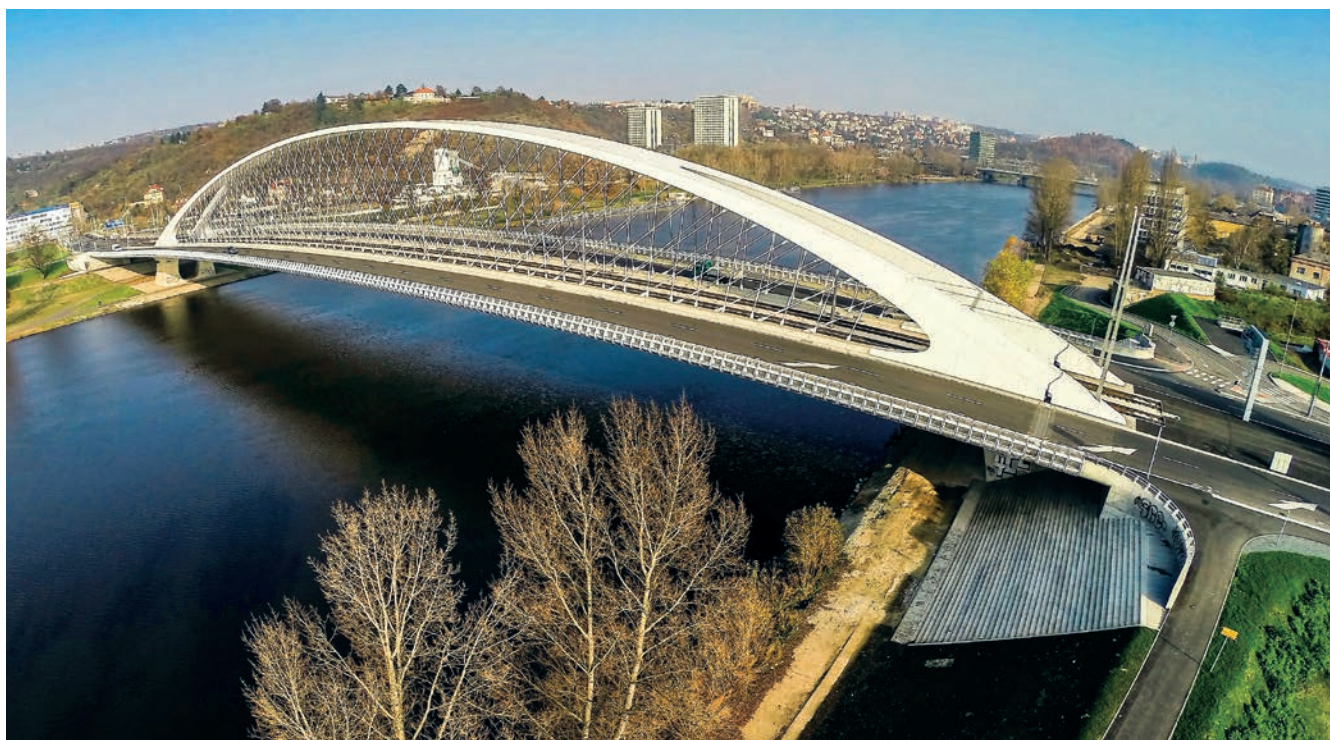
Síťová struktura táhel Trojského mostu v Praze
