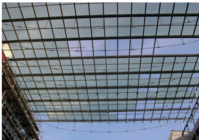
Palác Křižík v Praze – prosklené zastřešení atria (snímek z výstavby)
