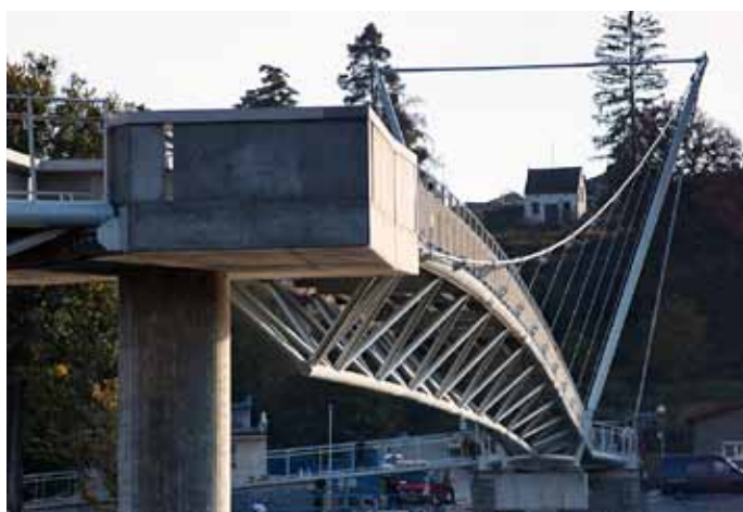
Obr. 5: Podesta na pilíři a visutá lávka
