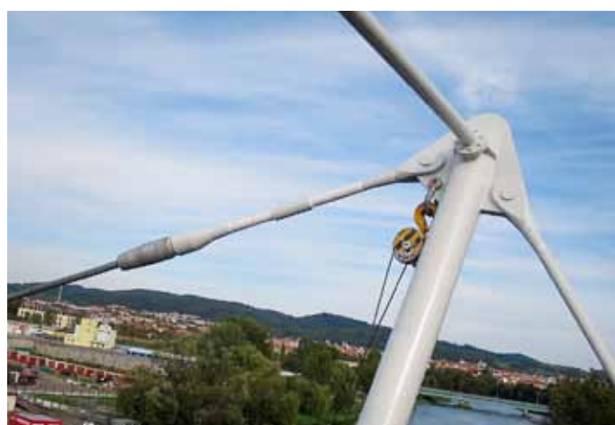
Obr. 6: Kotvení zadního táhla visuté lávky do horního pasu tělesa lávky
