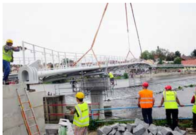
Obr. 11: Montáž tělesa lávky na opěru pilíře a montážní podporu v řece
