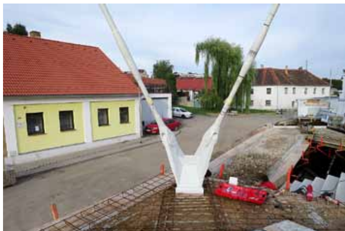
Obr. 15: Kotvení táhel zavěšené lávky
