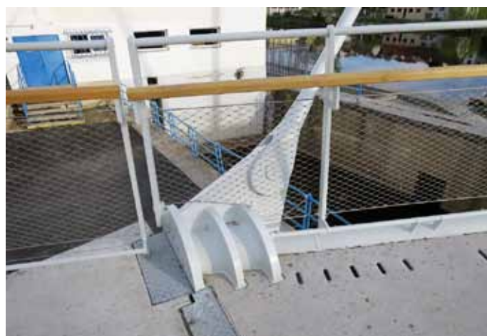
Obr. 6: Kotvení zadního táhla visuté lávky do horního pasu tělesa lávky
