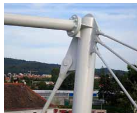
Obr. 16: Kotevní uzel zavěšené lávky
