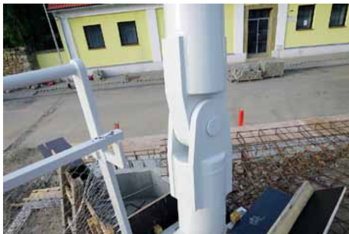
Obr. 14: Kloubové spojení pylonu zavěšené lávky
