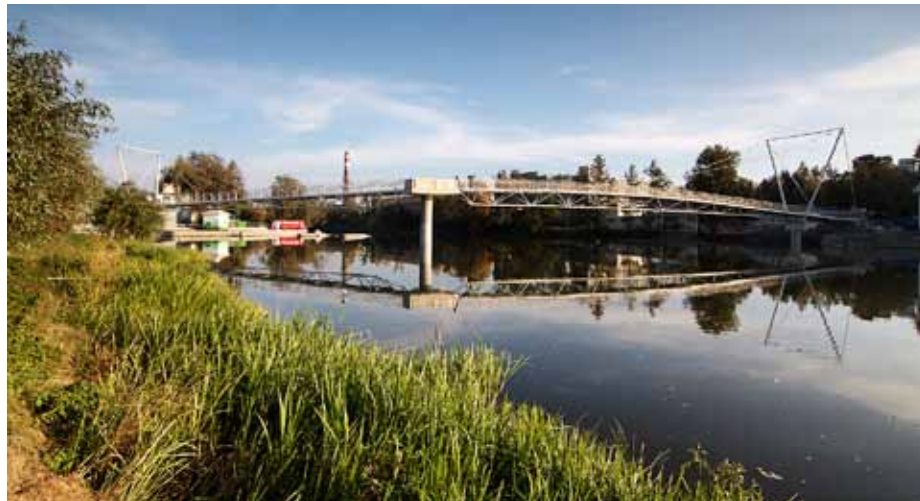
Obr. 21: Celkový pohled na lávku
