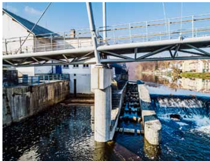
Obr. 4: Pilíř visuté lávky P1 u rybiho přechodu
