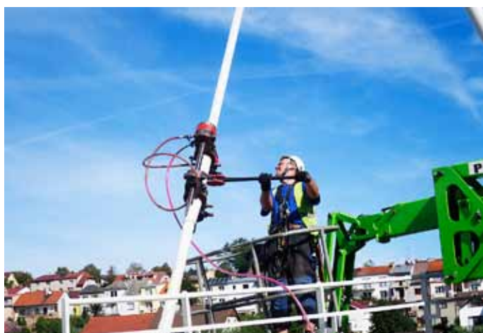
Obr. 12: Napínání táhel hydraulickým zařízením
