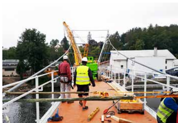
Obr. 13: Montáž závěsů; lana v horizontální poloze zajištěna stripy
