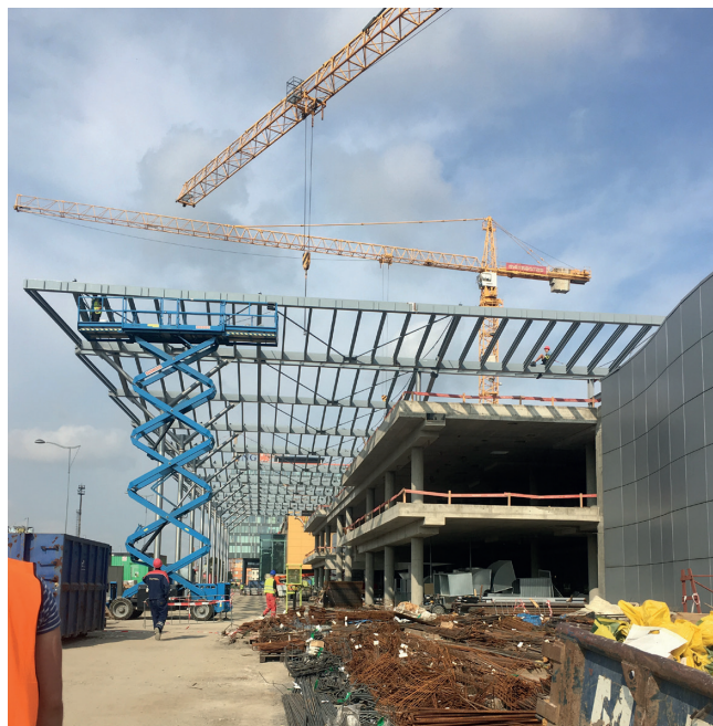
Montáž ocelové konstrukce markýzy
