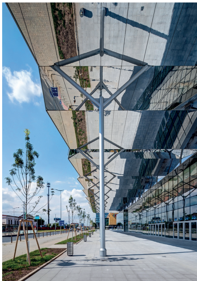
Pohled pod markýzu nad hlavním vstupem
