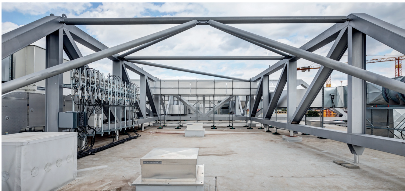
Pohled na ocelovou superkonstrukci nad sálem B
