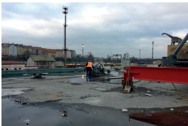
Zařízení pro hydrodemoliční práce
