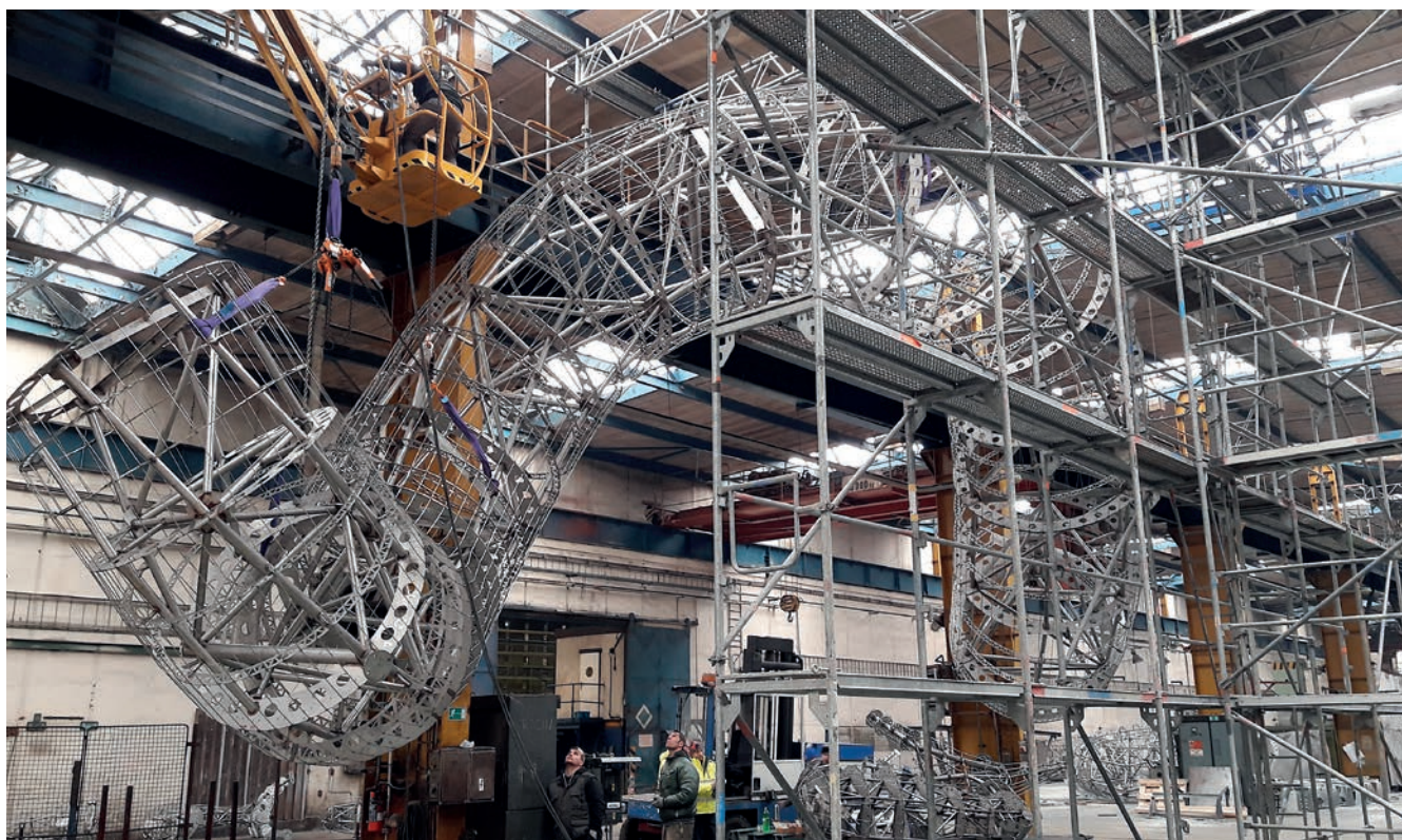
Obr. 8 – Pohled na částečně smontovanou základní konstrukci
