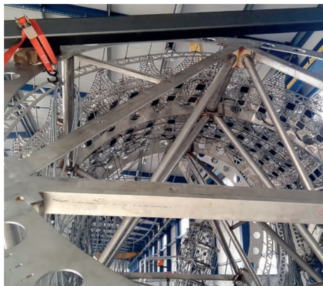
Obr. 6 – Předmontáž, detail konstrukce včetně prvků opláštění
