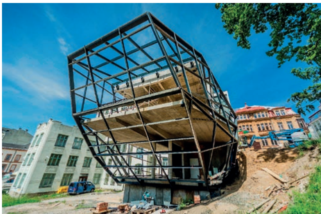
Ocelových konstrukcí bylo potřeba cca 15 tun
