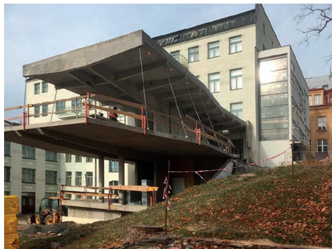
Železobetonový monolitický skelet
