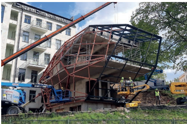
Montáž ocelové konstrukce
