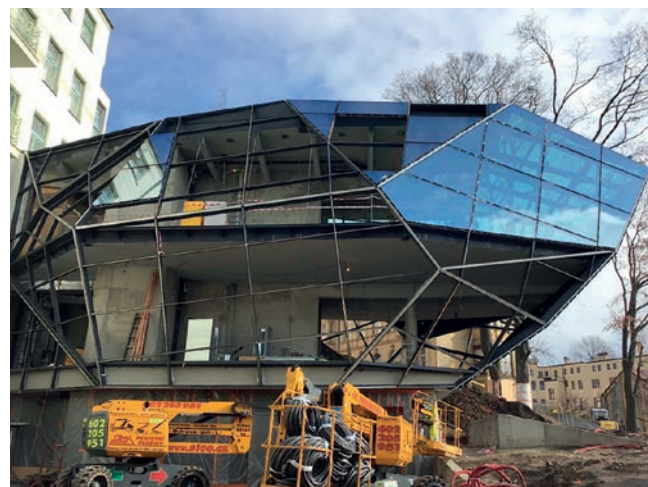
Realizace opláštění přístavby
