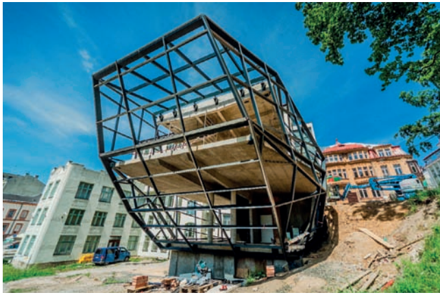
Ocelových konstrukcí bylo potřeba cca 15 tun
