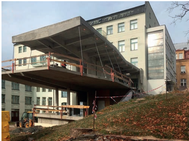
Železobetonový monolitický skelet
