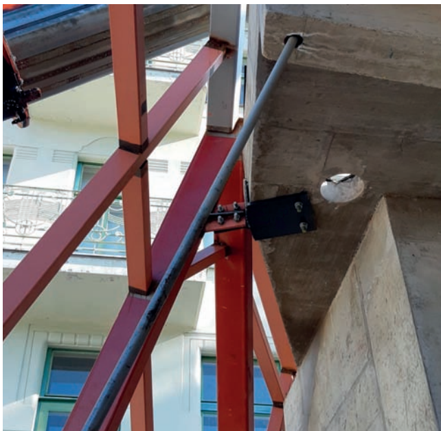
Detail kotvení
