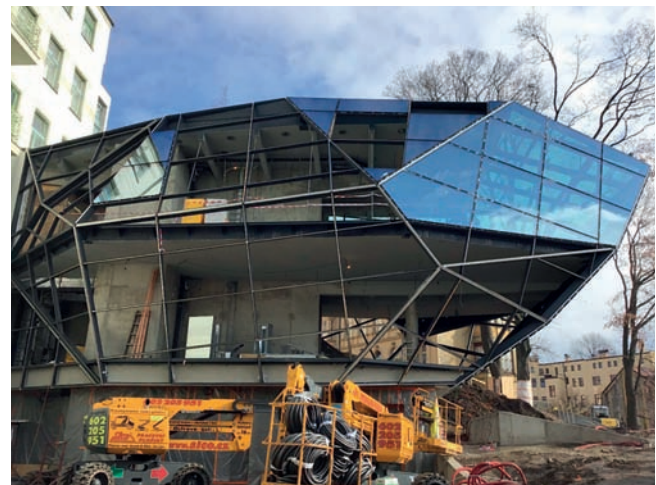
Realizace opláštění přístavby
