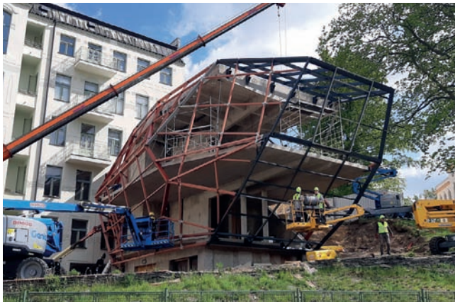
Montáž ocelové konstrukce
