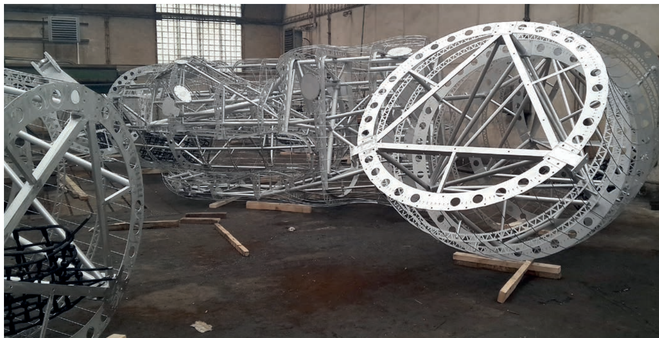
Obr. 7 – Hotové dílce, připravené na předmontáž
