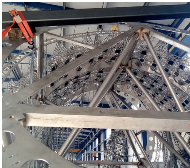
Obr. 6 – Předmontáž, detail konstrukce včetně prvků opláštění
