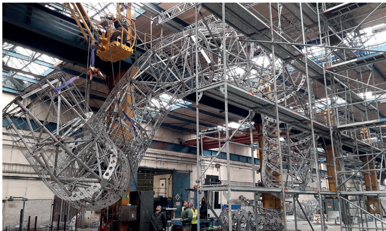
Obr. 8 – Pohled na částečně smontovanou základní konstrukci
