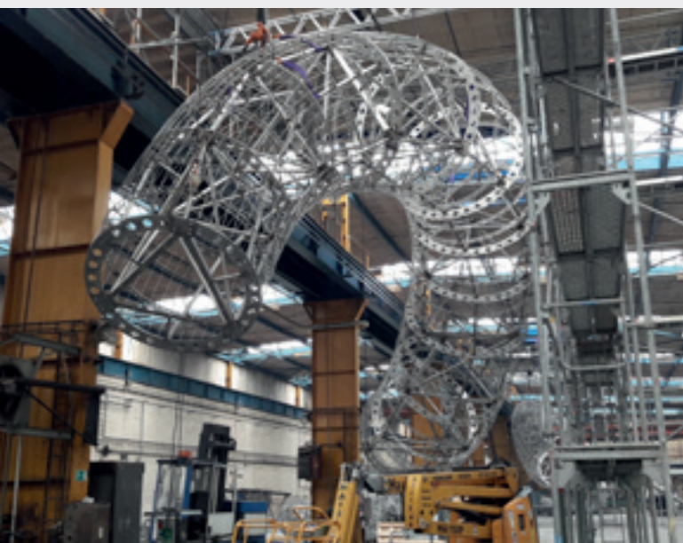
▲ Obr. 13 Částečně smontovaná základní konstrukce
