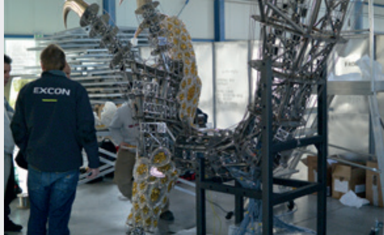
▲ Obr. 14 Dílčí kompletace konstrukce, opláštění a komponenty
