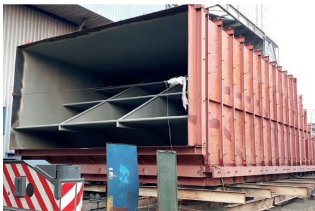
Nová konstrukce výstupního kouřovodu (tzv. outletu) ABS2, úroveň +25,4 metru
