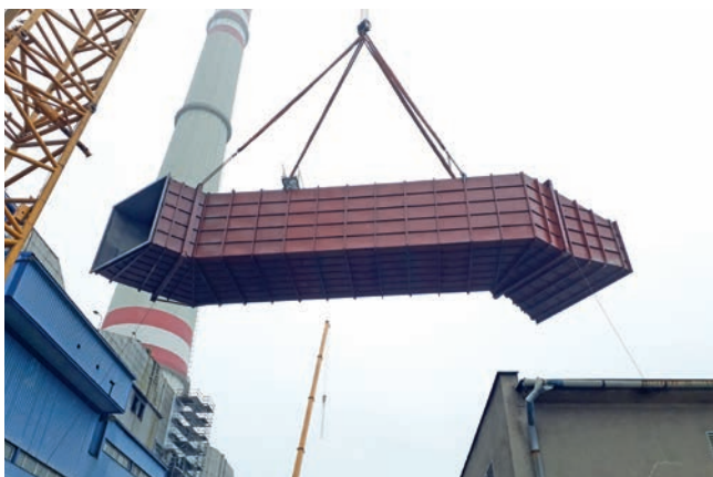
Montáž provizorního kouřovodu
