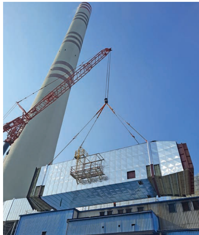
Montáž nového kouřovodu ABS1, včetně opláštění a technologických plošin
