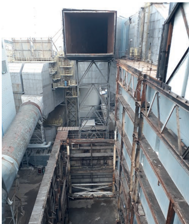
Stav objektu po dokončení demontáží poškozených konstrukcí ABS1
