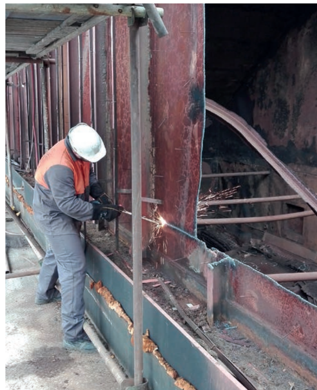
Postupná demontáž pláště tělesa ABS1, rozpalování na manipulovatelné dílce
