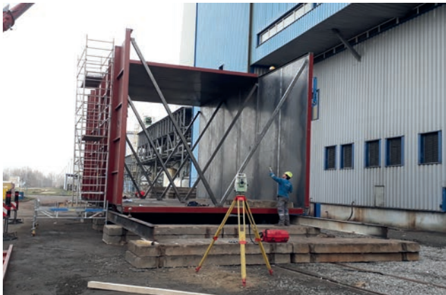
Montáž kouřovodu, sestavování z jednotlivých montážních dílců 4 × 5,6 metru
