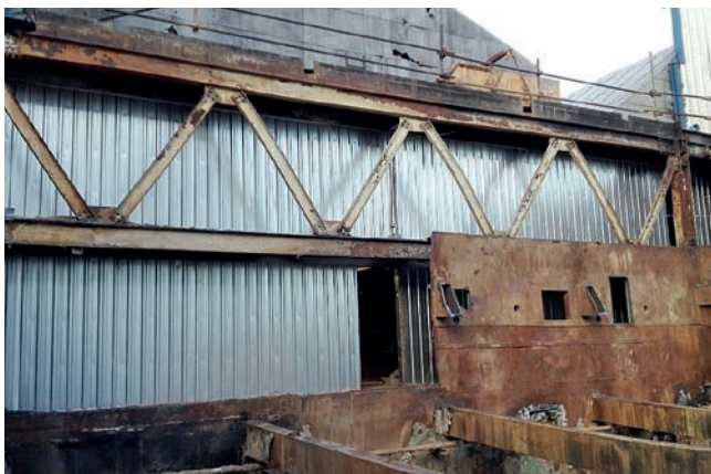
Postupná demontáž pláště – pohled na provizorní stěnu, oddělující provozovaný ABS2 od staveniště
