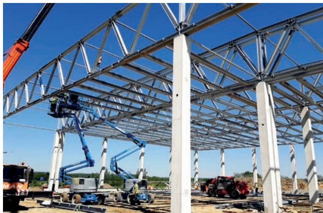
Momentka z montáže konstrukcí
