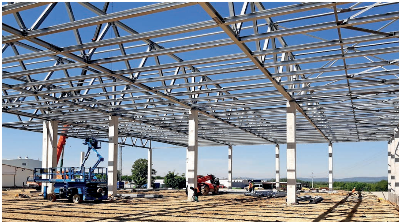
Pohled na dokončenou nosnou ocelovou konstrukci expediční části haly
