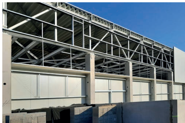
Pohled na sekundární konstrukce
