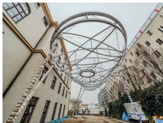
Dokončená ocelová konstrukce, pohled zespodu
