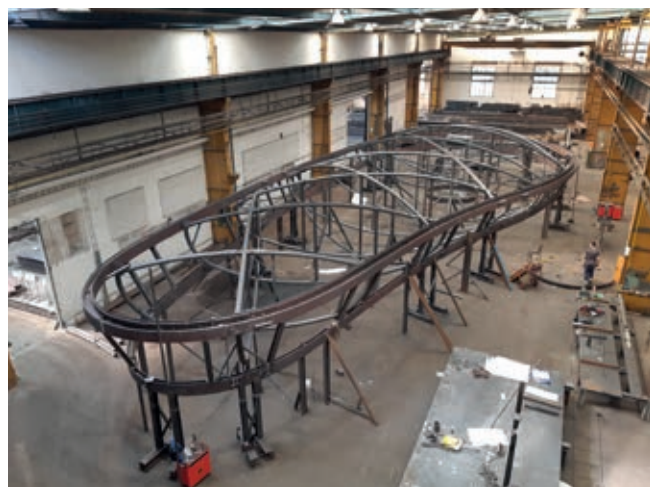
Dílenské sestavení horní části konstrukce
