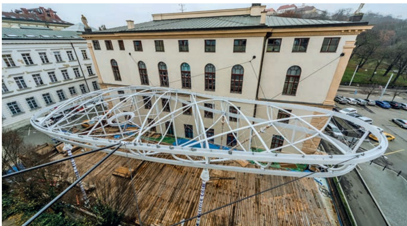
Dokončená ocelová konstrukce, pohled shora
