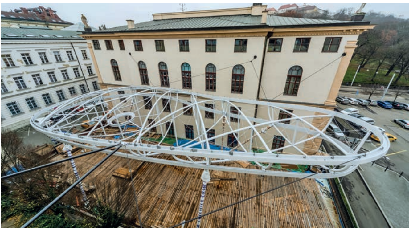
Dokončená ocelová konstrukce, pohled shora
