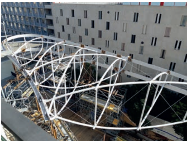
Montáž konstrukce na dočasných podporách
