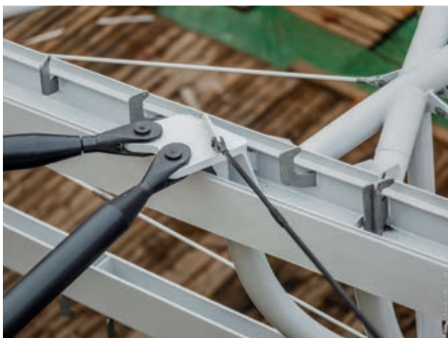
Dokončená ocelová konstrukce, detail napojení táhel a vzpěr
