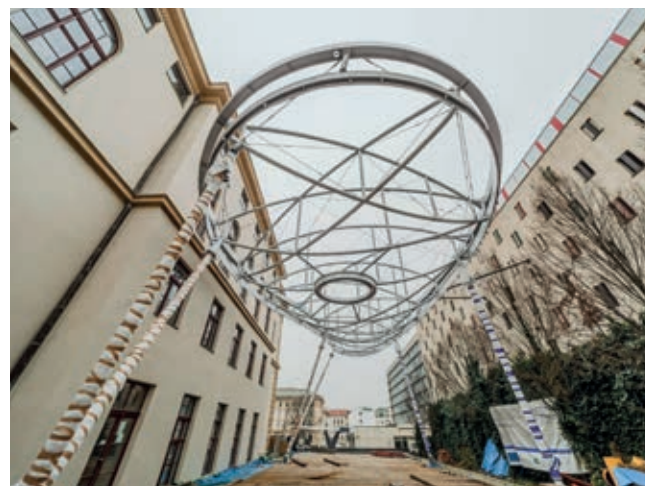
Dokončená ocelová konstrukce, pohled zespodu
