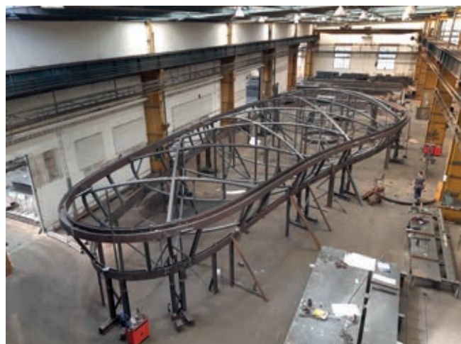
Dílenské sestavení horní části konstrukce
