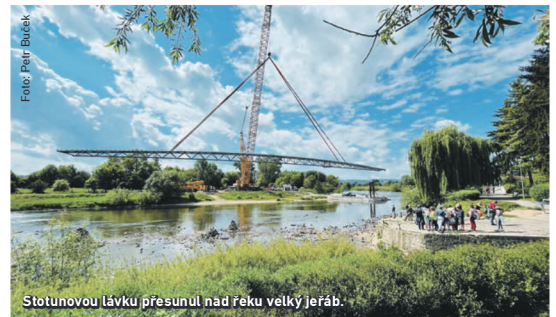
Stotunovou lávku přesunul nad řeku velký jeřáb.
