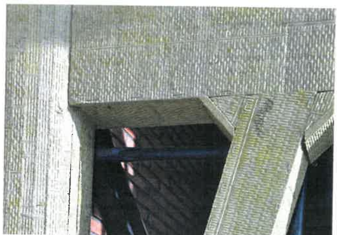
Aplikace protipožární izolace na bázi minerální vaty
