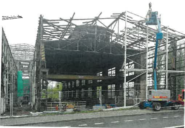
Snímky z rekonstrukce stávajících ocelových konstrukcí a montáže nových ocelových konstrukcí
