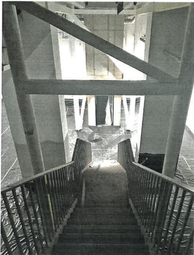
Ocelové schodiště, protipožární ochrana konstrukcí... (únor 2020)
