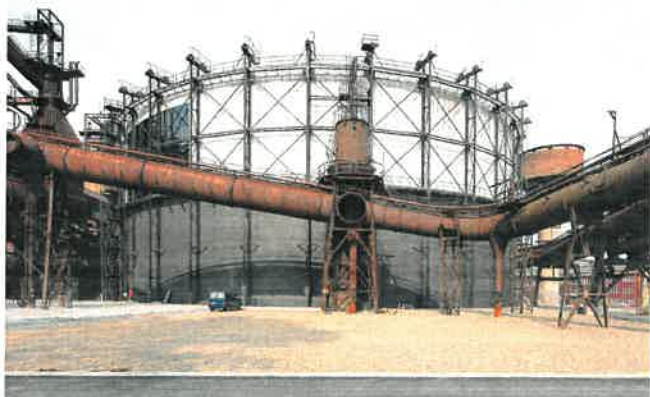
Multifunkční hala Gong
