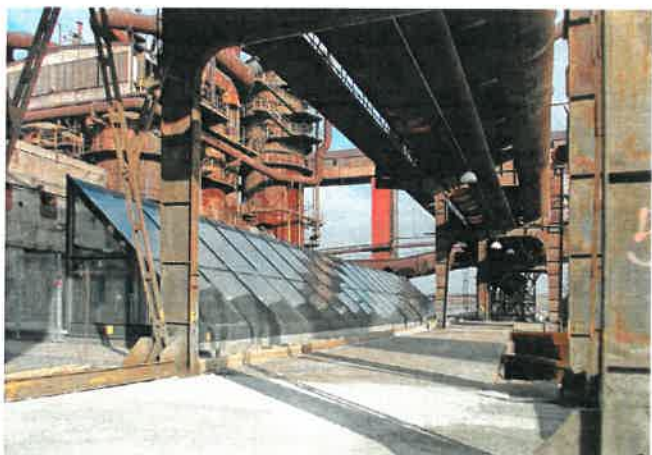
Energo centrum s ocelovou konstrukcí světlíku
