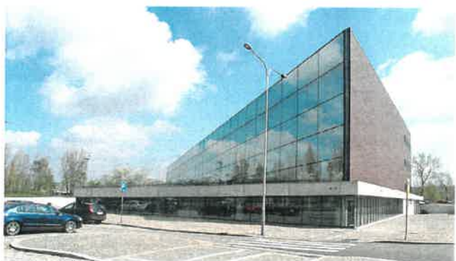
Nový svět techniky s ocelovou konstrukcí čelního prosklení
