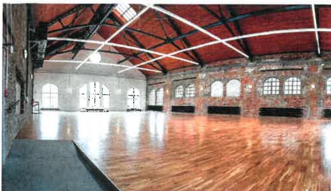
Hlubina – staré koupelny s původní ocelovou konstrukcí zastřešení
