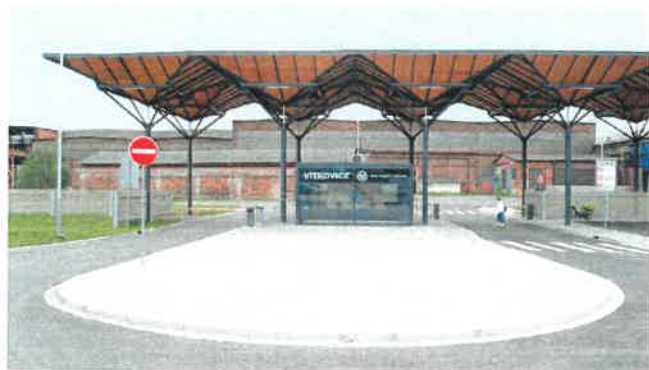
Nová vrátnice s uplatněním ocelových konstrukcí
