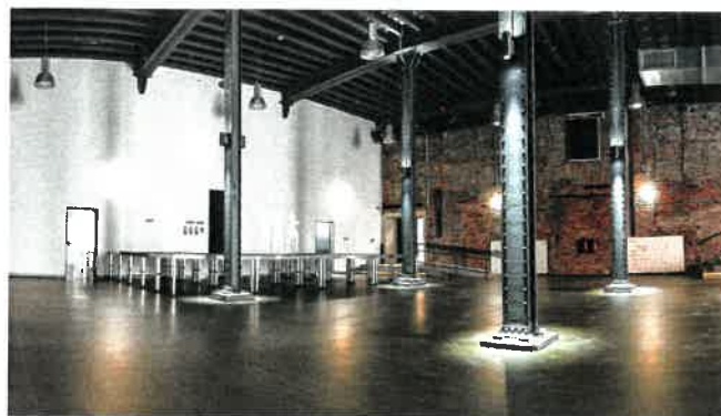
Hlubina – staré koupelny s původními nýtovanými konstrukcemi
