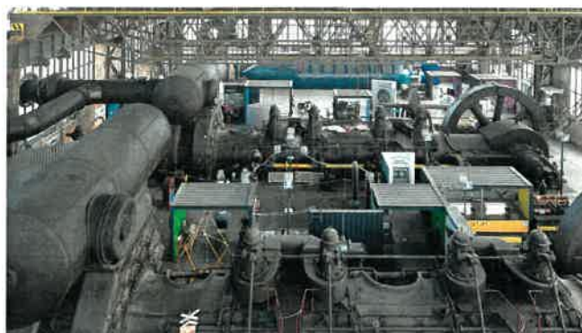
Šestá ústředna s původními ocelovými konstrukcemi
