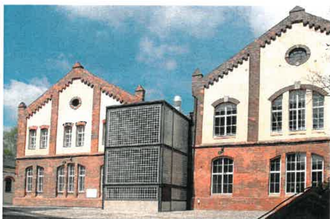
Hlubina – staré koupelny s ocelovou dostavbou únikového schodiště
