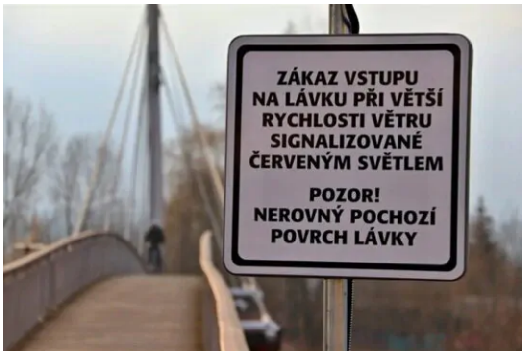
Původní poškozená lávka byla vybavena semaforem napojeným na měřič rychlosti větru. Zdroj: Praha 16
