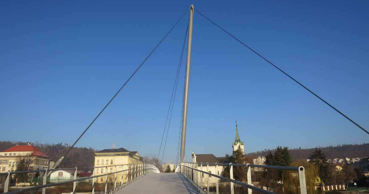
▲ Obr. 22 Lávka po zprovoznění, pohled od rozšířené zbraslavské opěry
