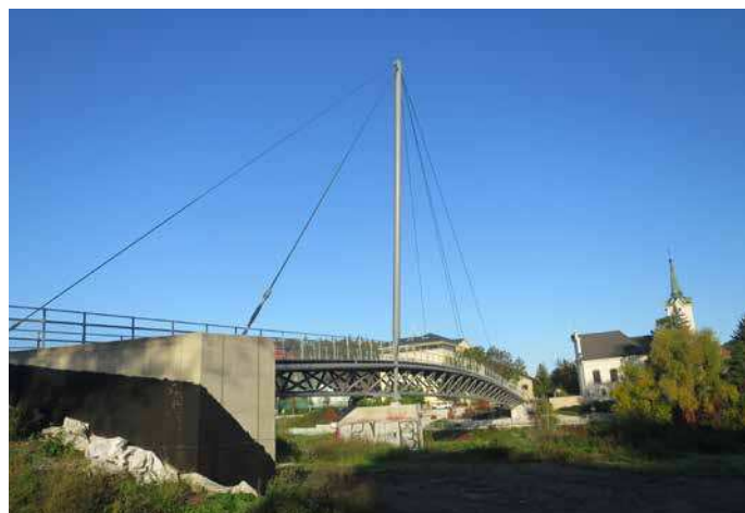
▲ Obr. 13 Rozšíření zbraslavské opěry s dvojicí lanových závěsů
