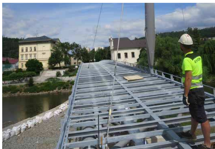
▲ Obr. 17 Pylon po zakotvení třemi montážními táhly
