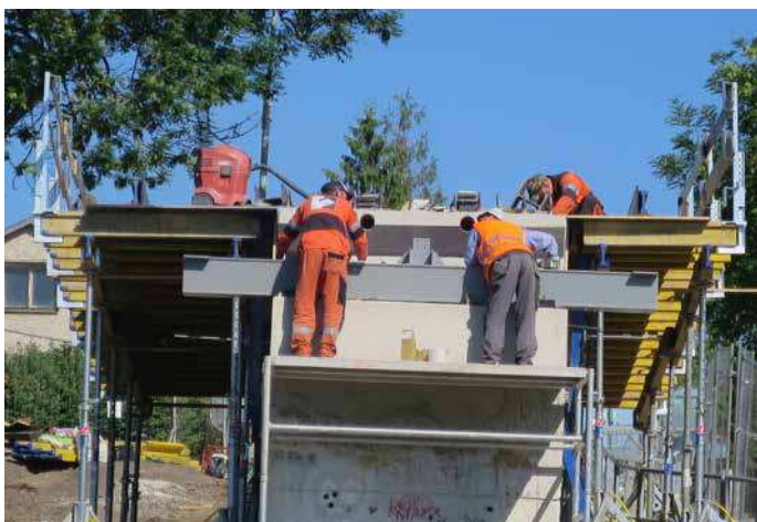
▲ Obr. 12 Rozšíření mostovky a nosník s konzolami pro uložení lávky na radotínské opěře
