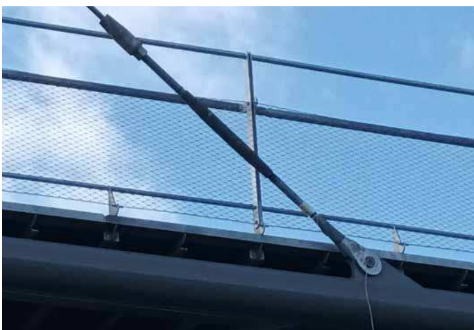
▲ Obr. 8 Lana jsou na povodní straně kotvena přímo do horního pasu příhradové nosné konstrukce
