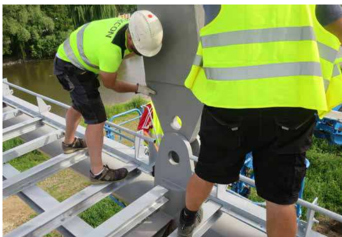
▲ Obr. 16 Začepování pylonu
