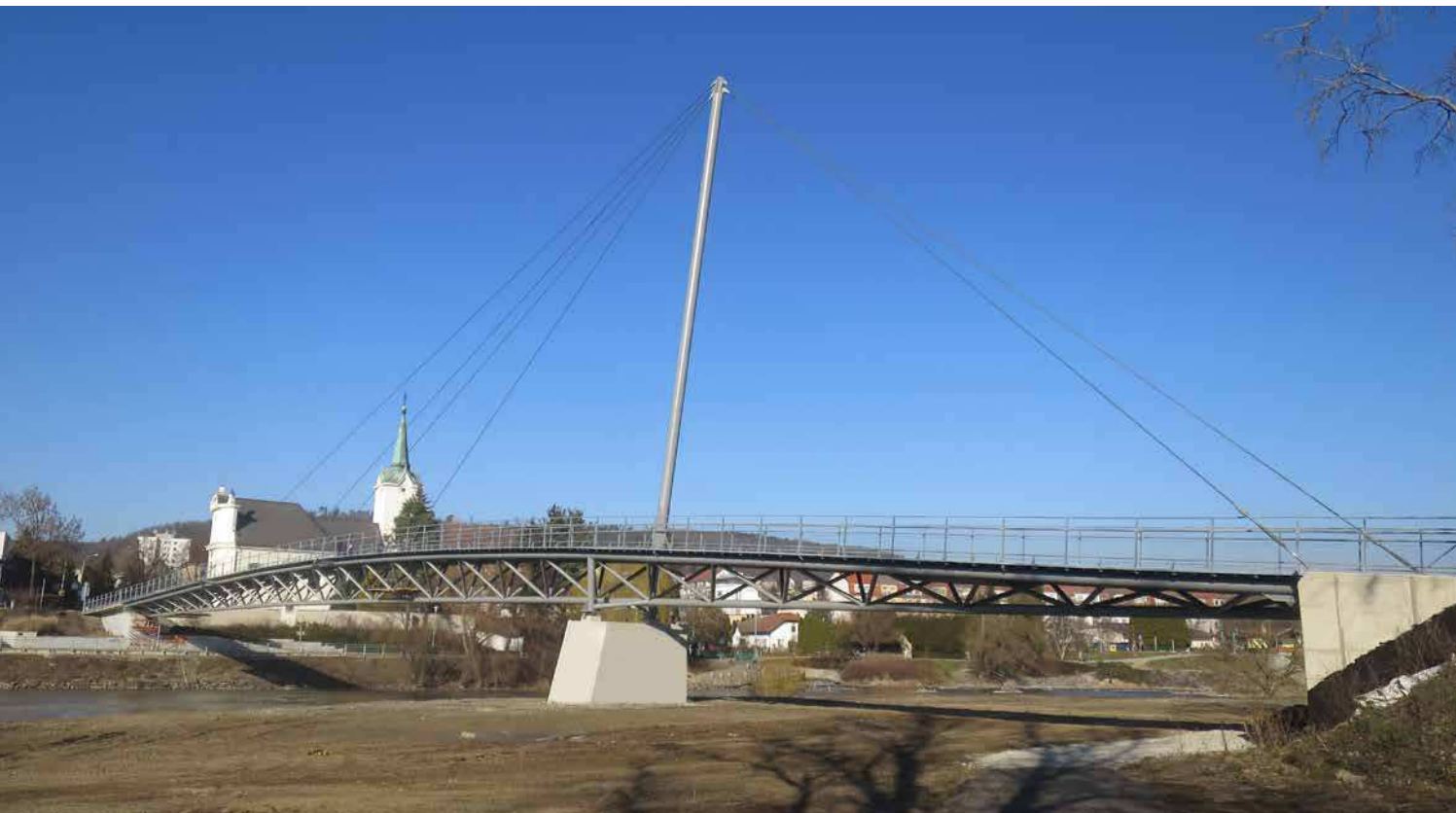
▲ Obr. 1 Nová zavěšená lávka pro pěší a cyklisty v Radotíně na spodní stavbě původní lávky
