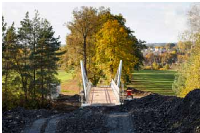
Lávka v Mníchově Hradišti
