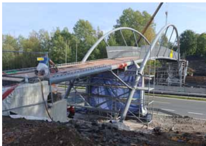
Lávka Mnichovo Hradiště
