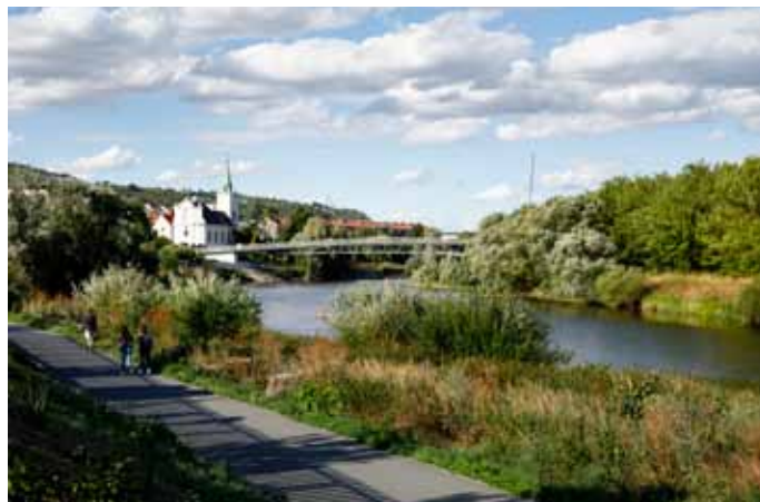
Lávka v Radotíně
