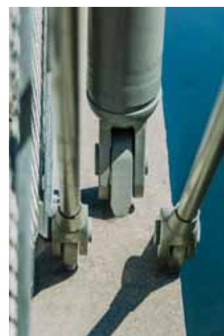
Lávka Mladá Boleslav, kotvení prvků do spodního pasu
