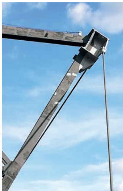
Rozšíření kotvení trapézů (vlevo) a prstenců (vpravo) – realizace.
