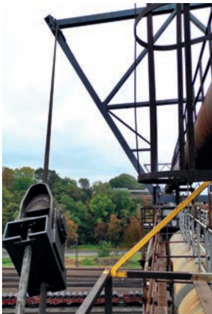
Zakončení lana napínací sestavou konstrukčního systému táhel.
