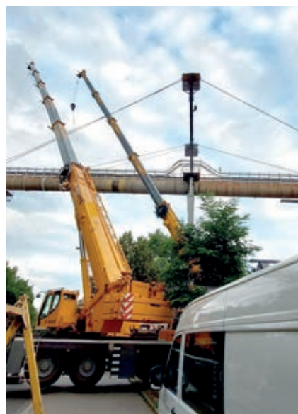
Rozšíření trapézů (nahore) a montáž lan (dole).
