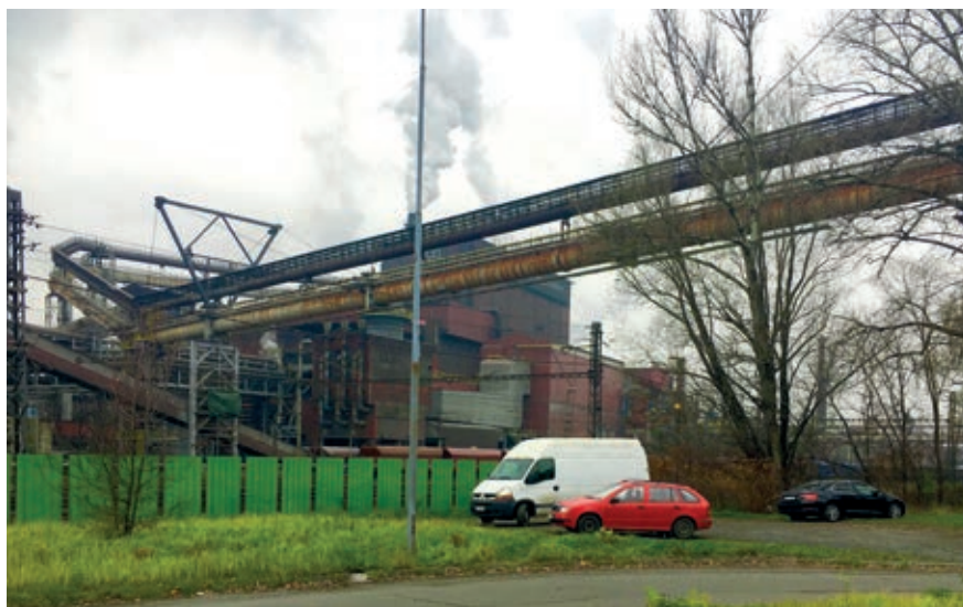
Potrubní most před rekonstrukcí.
