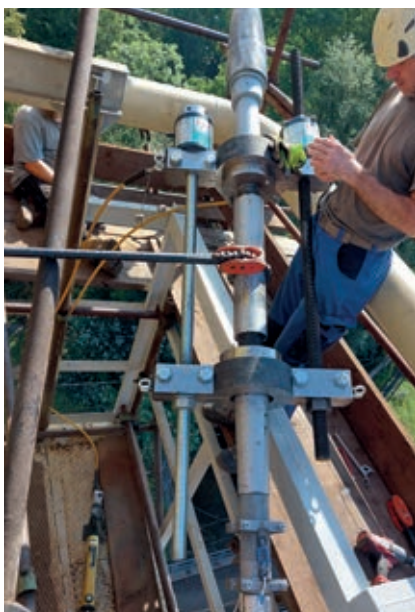
Původní napínací zařízení (nahore) a nové napínací hydraulické zařízení a tenzometr (dole).
